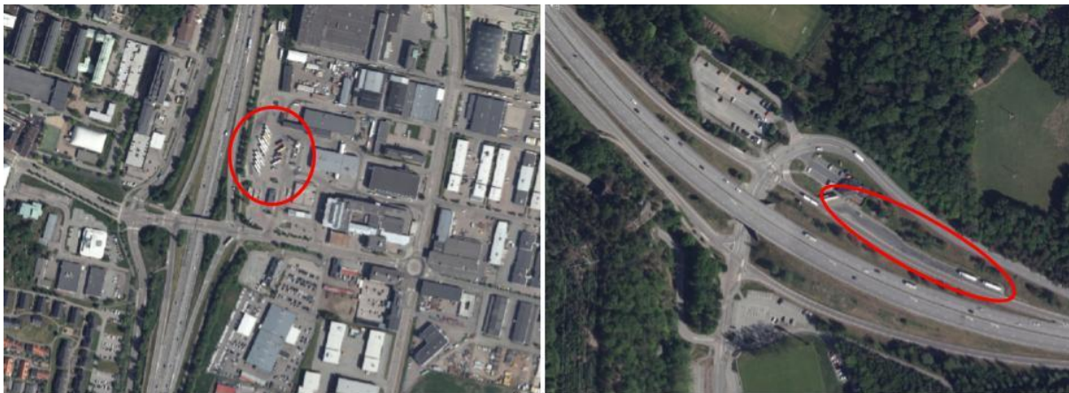
Satellitbilder på Importgatan (bild 1, vänster) och Kallebäck/Delsjömotet (bild 2, höger) (Lantmäteriet, Mina Kartor)
