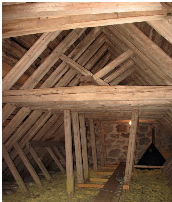
Taklag i Bälaryds kyrka, Småland. Störbjälke på hanbjälkarna.
