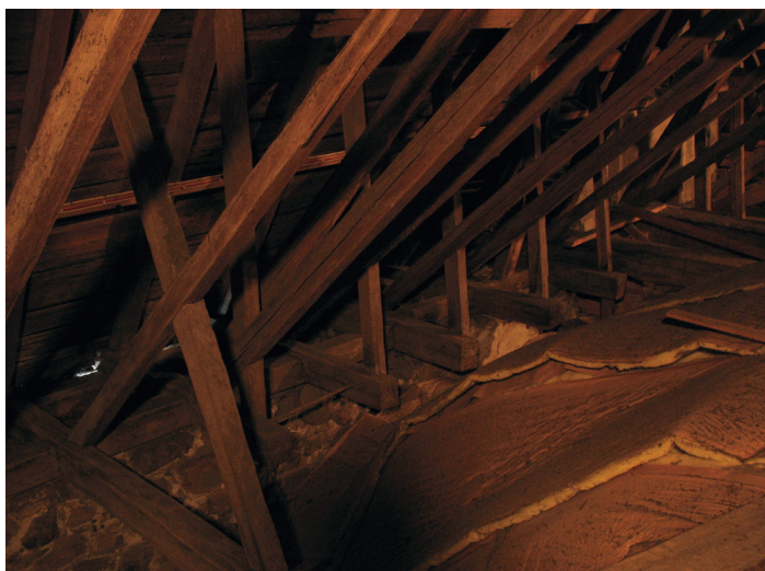
Säby kyrka, Småland, taklag anpassat för valv. Primärtakstolarna mellan valven har bindbjälke medan sekundärtakstolarna har tass och stickstöta (s.k. knäbock), i övrigt saxsparrar och hanbjälke.
