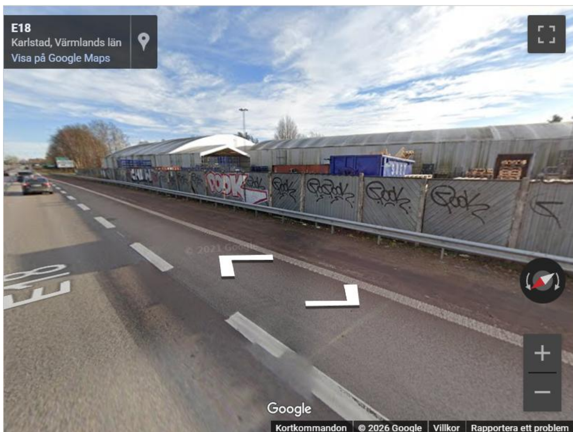
Bilaga 8: ID.46 år 2020. Bild Via Google Street View
