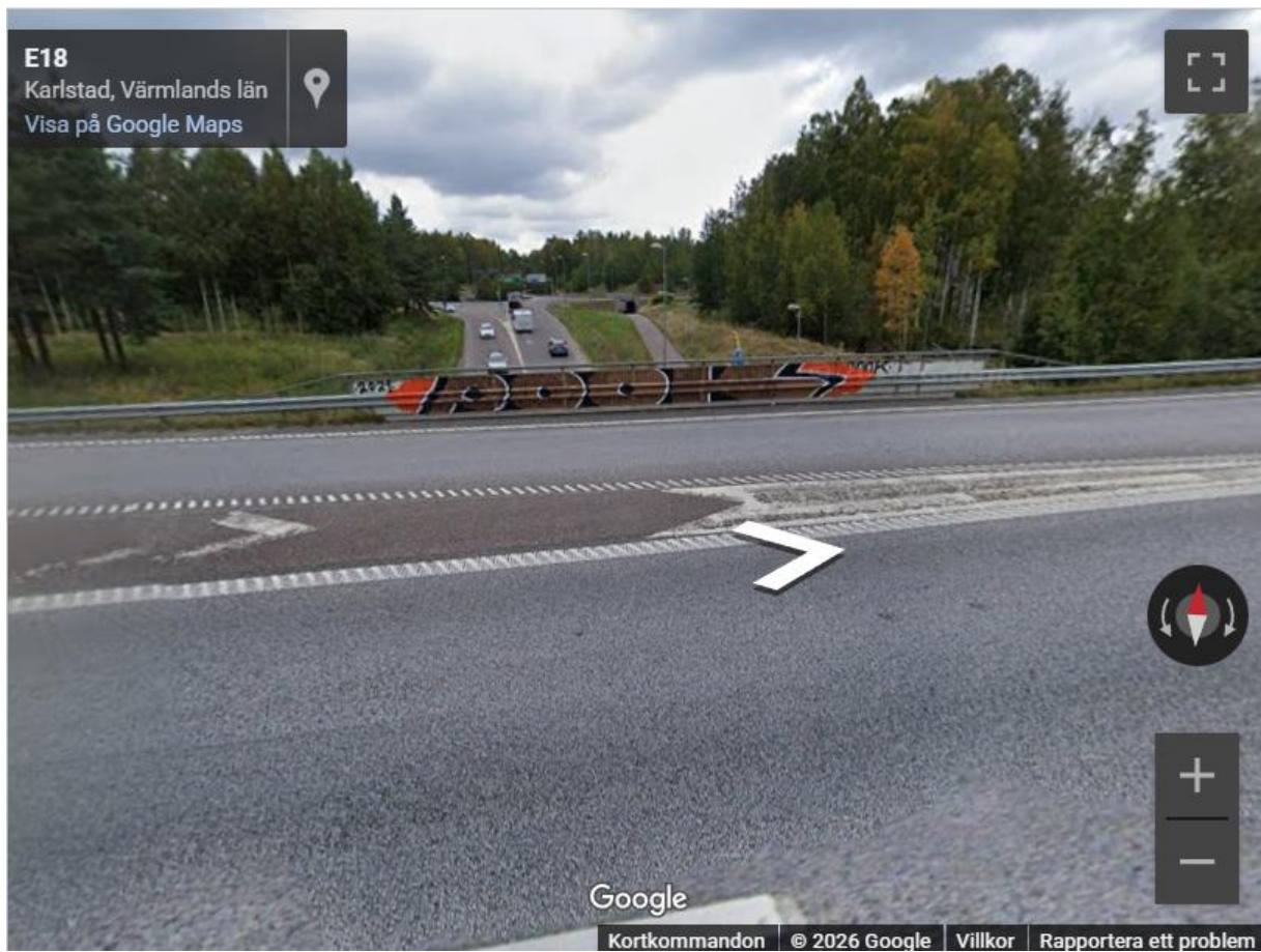
Bilaga 10: ID.53 år 2022. Bild via Google Street View.
