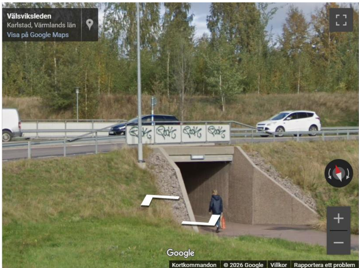
Bilaga 12: ID.53 år 2020. Bild via Google Street View
