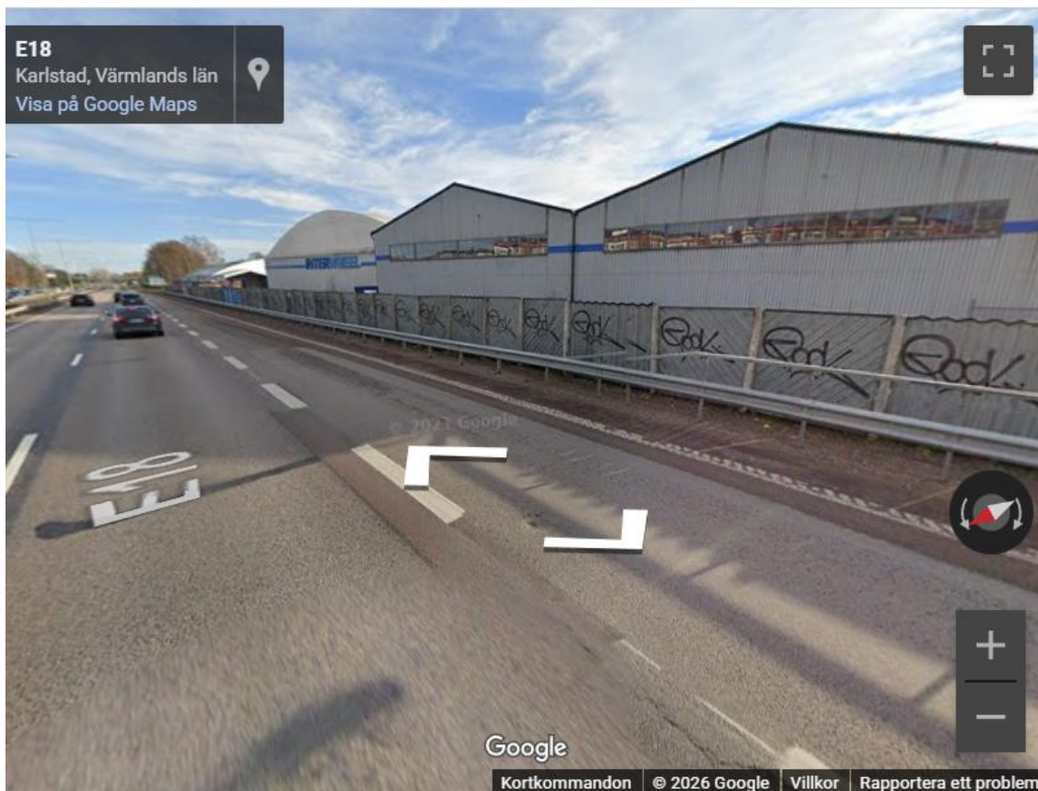
Bilaga 7: Id 46 år 2020. Bild via Google Street View.
