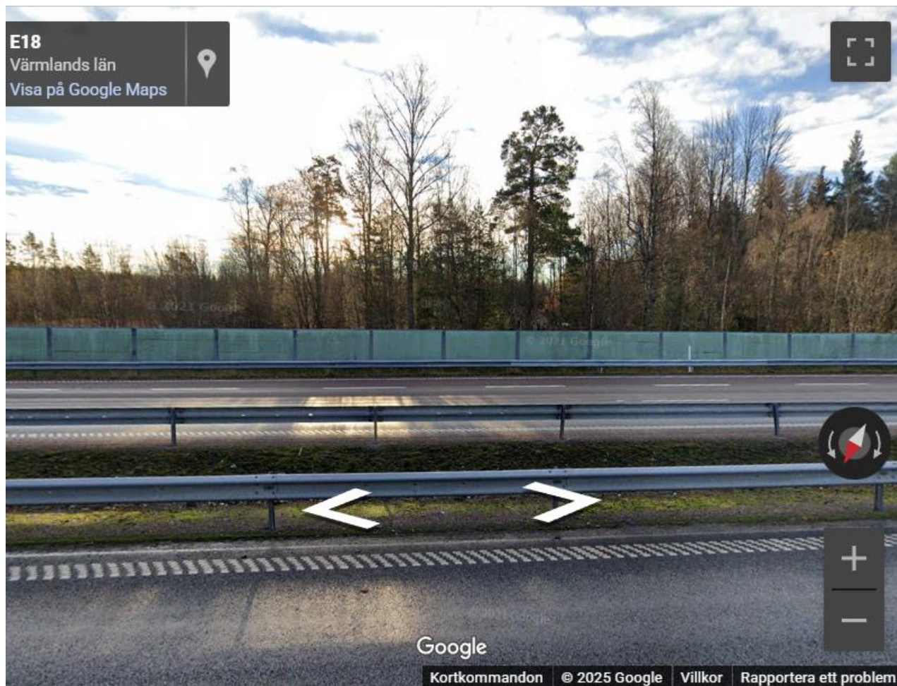
Bilaga 5: ID.25 november 2020 från andra filen. Bild via Google Street View.
