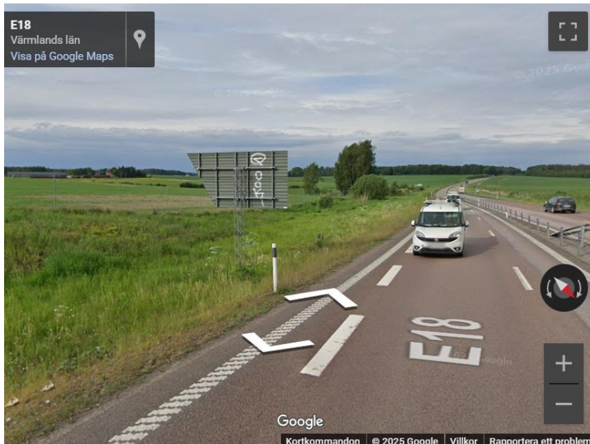
Figur 18. Pook på baksidan av en skylt. Bild tagen via Google Street View.
