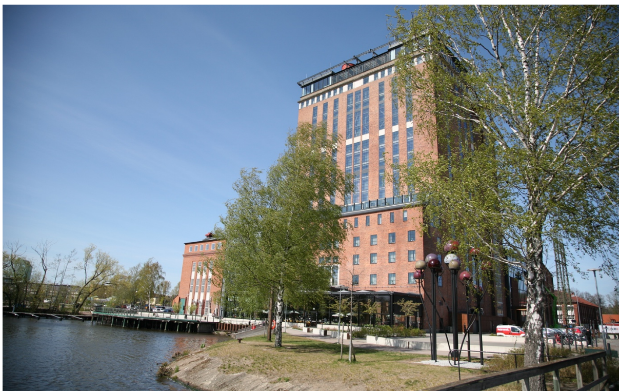
Figur V:05. Ångkraftverket som det ser ut i dag. Hotellet huserar i den fd tornpannebyggnaden, nytt skott i form av ett orangeri mot Mälaren har byggts till och på taket är en våning tillbyggd. Fotograf Camilla Häggman 2022.
