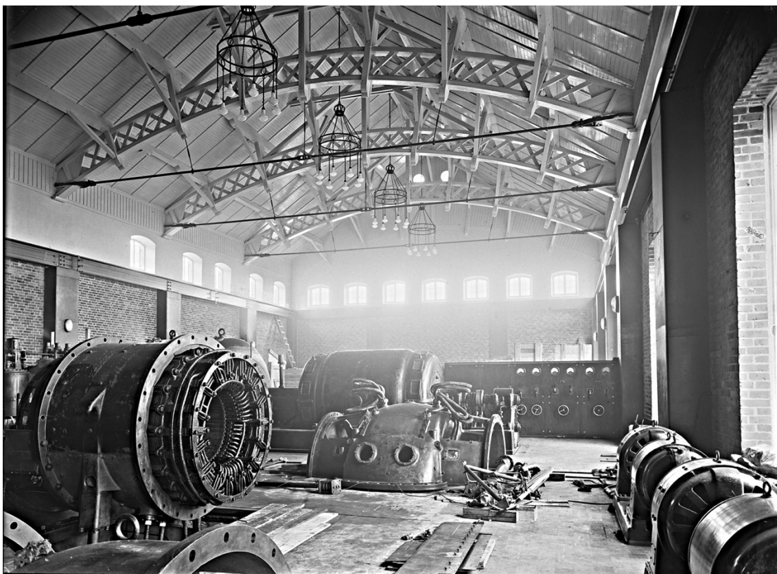
Figur V:02. Interiör av ångkraftverkets maskinhall. Ritad av Erik Hahr, med valvbågar i trä och ljuskronor i taket, 1920-tal. Fotograf Ernst Blom. Västmanlands läns museum.
