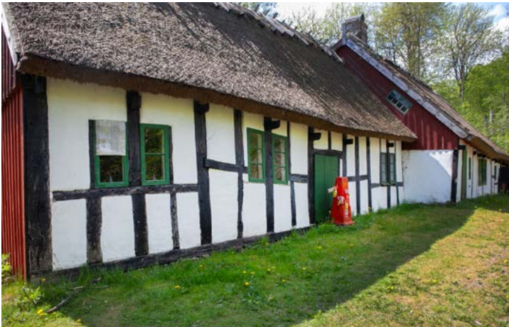
Boningshus i korsvirke vid Blåherremölla strax söder om Maglehem.
