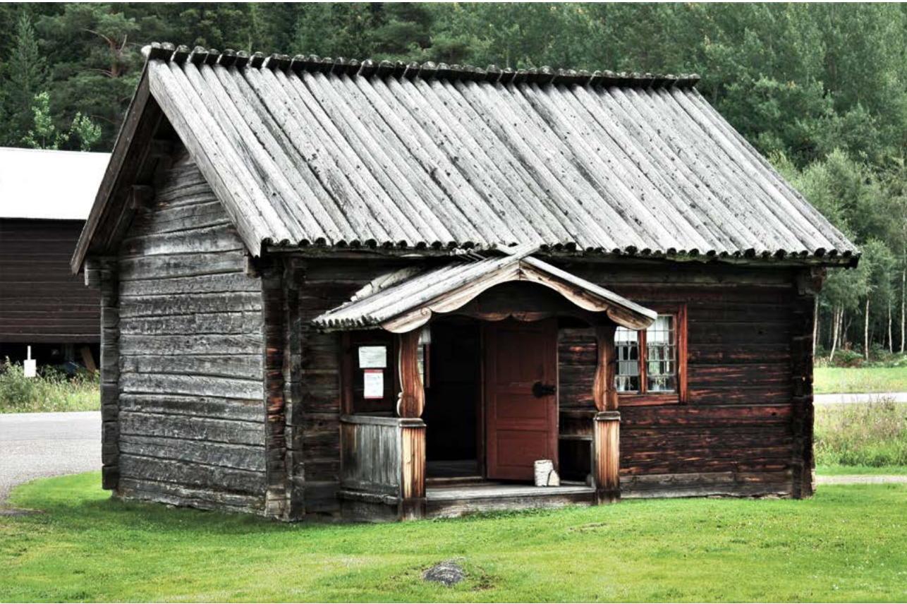
Tak av kluvna klens stockar på en liten stuga i Hälsingland, ett så kallat vedtak.
