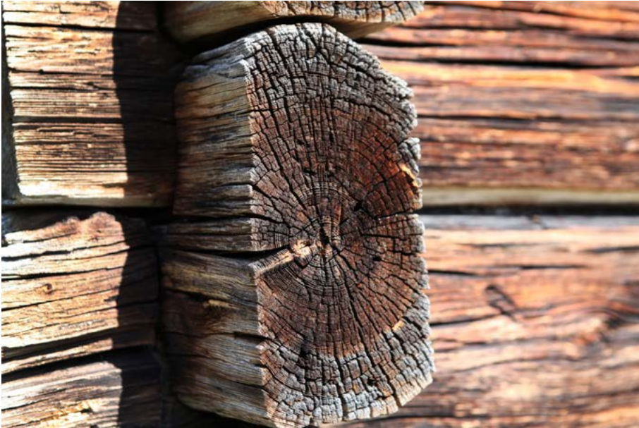
En timrad knut där man efter mer än 100 år klart ser skillnad mellan stockens mörka kärna och ljusare splint.
