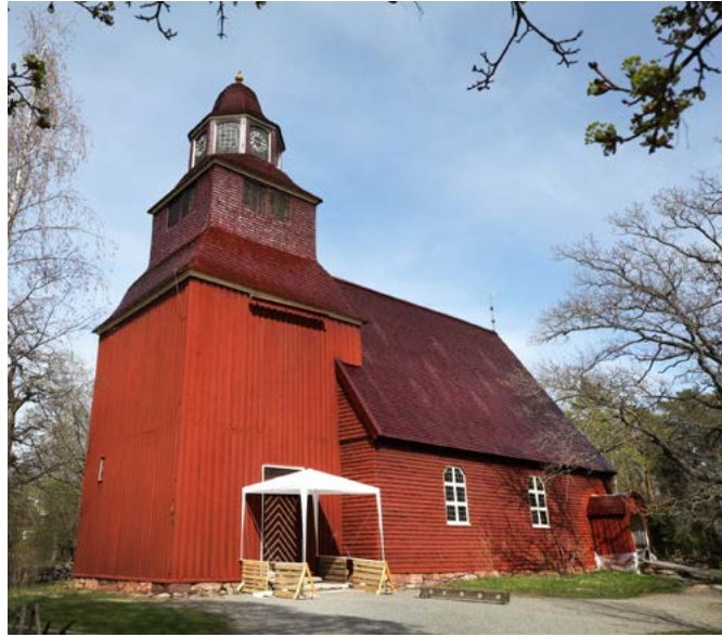
Seglora kyrka. Timmervarven upp till fönstren är av ek och därefter furu.
