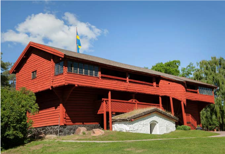
Ornässtugan, ett knuttimrat hus från 1505, där Gustav Vasa övernattade under sin flykt undan danskarna.
