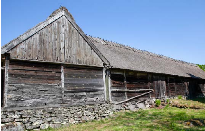
Fähus utfört i skiftesverk vid Skånes hembygdsförbund gård Ballingstorp strax söder om Hanaskog. Skiftesverket är utfört med både ek- och furuplank.
