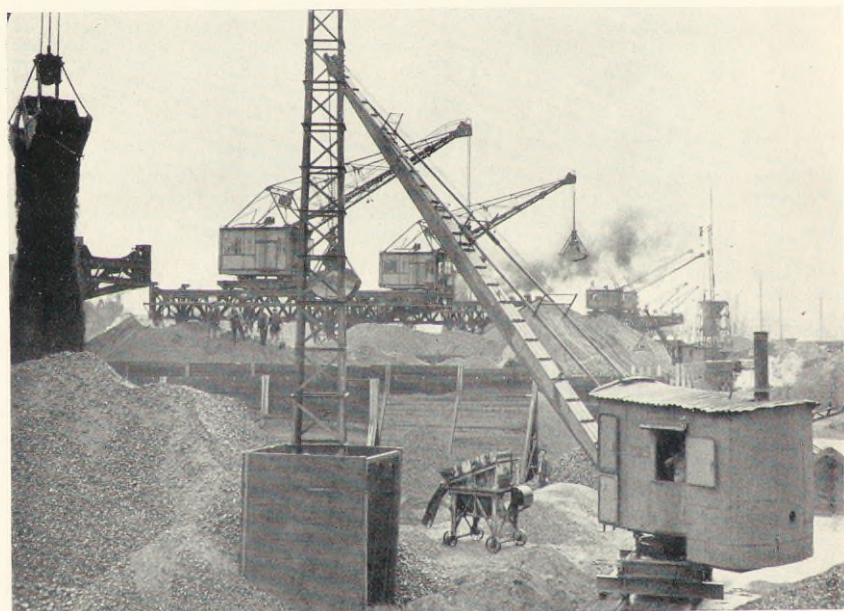
Arbetet vid lastageplatserna fortgår som vanligt. Det tycks vara gott om kol!
