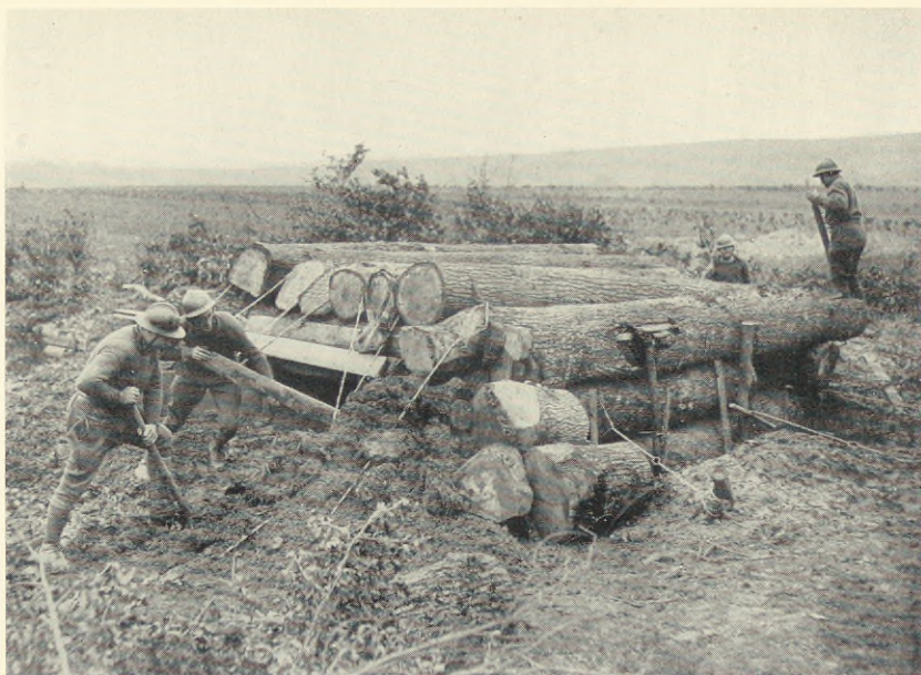
Skyddsrum i terräng.
