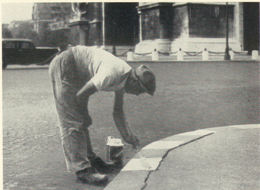
Till ledning åt trafikanterna under de mörka timmarna markeras trottoarkanterna med vitt.
