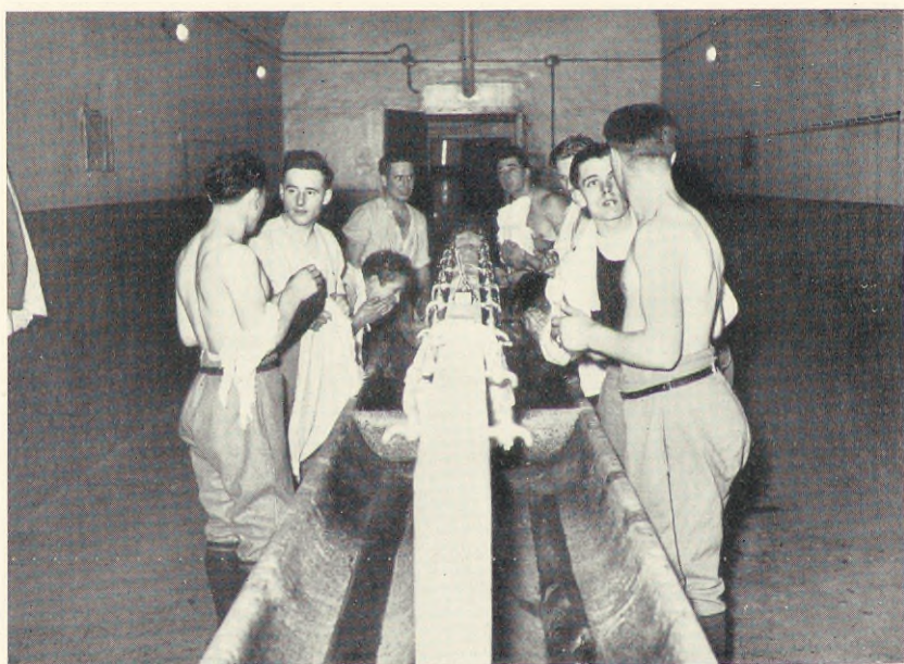
Ett av de välbelysta tvättrummen. Ordentliga duschinrättningar finns även.
