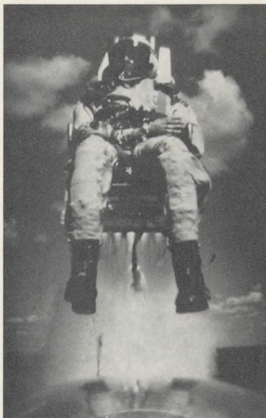
Figur 8. Raketstol för fpl 35 »Draken». Utskjutning ur flygplan.
