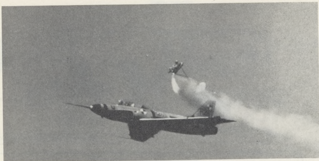
Figur 9. Raketstol för fpl 35 »Draken» utskjutning ur provplan V_i = 820 km/tim.
