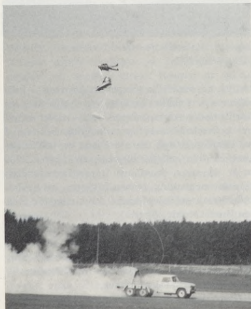
Figur 7. Raketstol för fpl 35 »Draken». Uppskjutning från bil.
