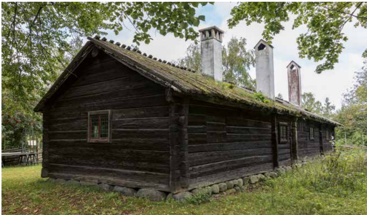
BILD 115. Baksidan, där de anmärkningsvärda timmerdimensionerna framgår, liksom det igensatta fönstret på herrstugan och att det är två hopsatta byggnader, två olika typer av knutar. Foto: Peter Hoelstad.
