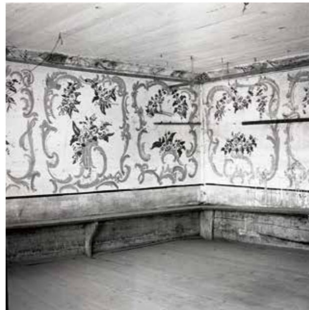
BILD 101. Herrstugan. Bild tagen före renoveringen. Notera hur golvet är ojämnt. Foto: Hilding Mickelsson.
