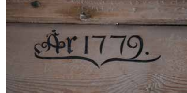
BILD 175. På främsta bänkens psalmbokshylla på norra sidan finns även årtalet 1779 skrivet. Förmodligen nytillverkades delar av det främsta bänkartiet, då det tidigare fanns stolpar som bar koraläktaren där. Den trävita ytan har sakta bränts ned av solens strålar under snart 250 år, medan ytan under årtalet – som nu är i relief – har skyddats av den svarta färgen. Foto: Lars Nylander.
