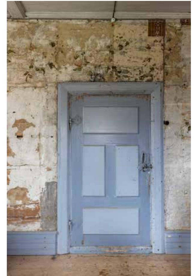
BILD 102. Östra kammaren. Väggar är till stor del täckta av skyddsklistring. Foto: Peter Hoelstad.
