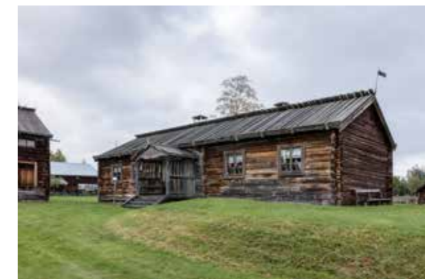
BILD 62. Svensas herrstugsbyggnad som Norrbergsstugan på Delsbo forngård. Förändringar om utseendet jämförs med föregående bild: Byggnaden har sänkts tre stockvarv. Panelen saknas. Fönstren har gjorts en ruta mindre. Förstukvistens sidoribbor har en annan form. Foto: Peter Hoelstad.
