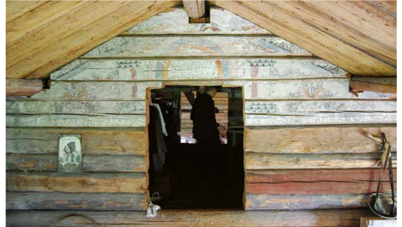
BILD 13. Gavelröste som en gång varit gavelvägg i en ryggåsstuga men nu återfinns på en vind. Mellan timmerstockarna har tyngrensor varit klistrade, men vid återanvändningen har de rivits bort och de saknas nu. Daterat 1737. Nygårds i Vängsbo, Ovanåkers socken. Foto: Lars Nylander.
