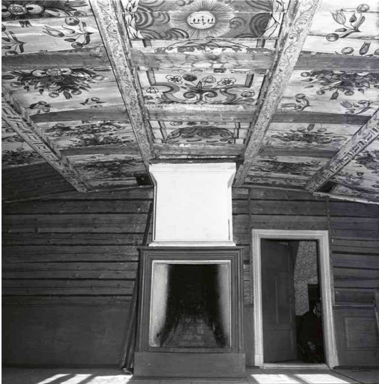
BILD 46. Herrstugan i Wallins med nedtagna väggmålningar och blottat tak i samband med konserveringen 1965. Foto: Hilding Mickelsson.
