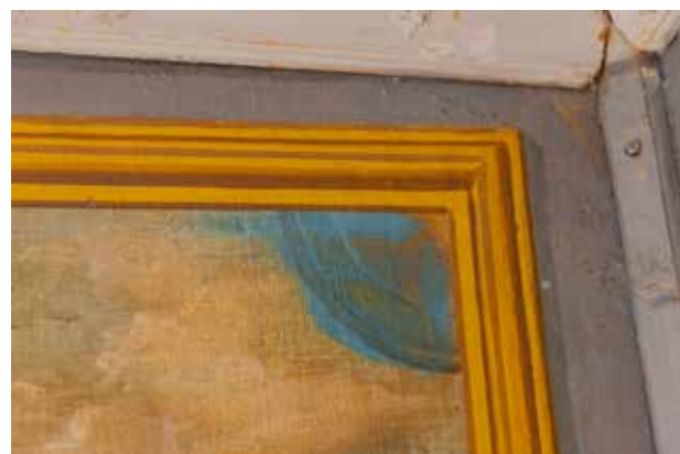
BILD 57. Paul Hallbergs inredning hade brun bottenfärg och runt motivframställningarna var ramar med rundade hörn i överkant målade. Jonas Wallström moderniserade ramarna 1842 då de blev raka. Hallbergs svängda ramar skymtar i de övre hörnen. Foto: Peter Hoelstad.
