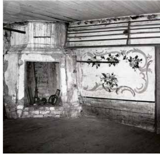
BILD 100. Herrstugan. Bild tagen före renoveringarna. Notera hur spisen är sprucken. Foto: Hilding Mickelsson.
