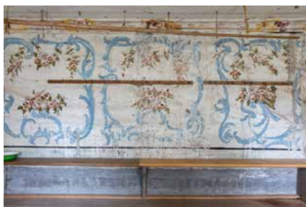
BILD 95. Herrstugan. Norra väggen. Foto: Peter Hoelstad.
