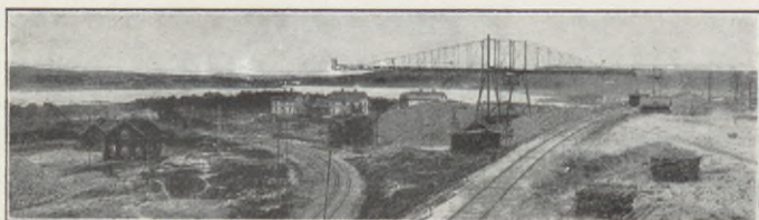
Malmstakranen på Svartön, Luleå.
