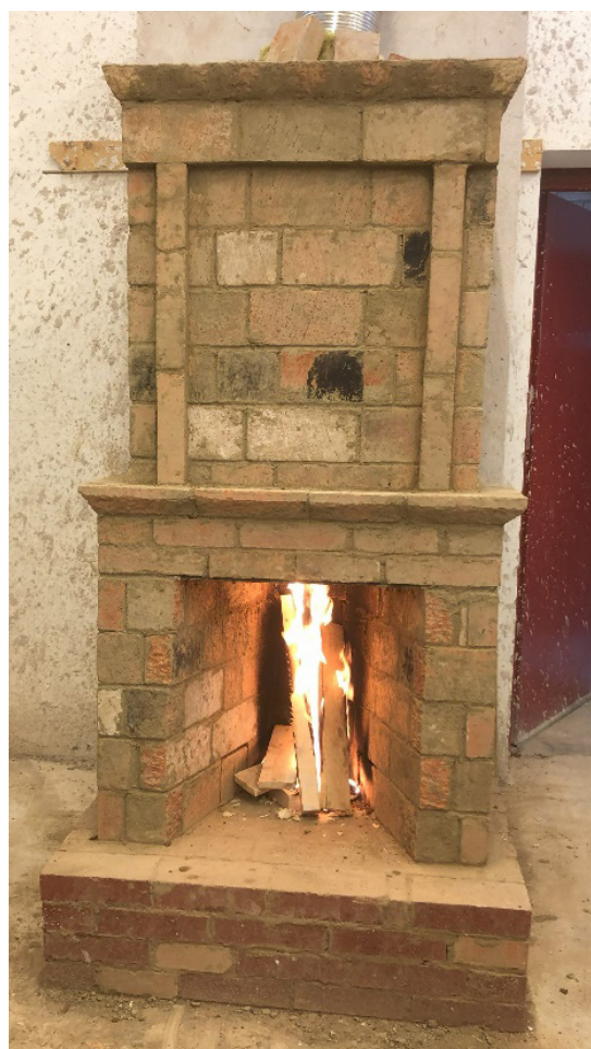
Figur 32. Den färdiga spisen test-eldas.
