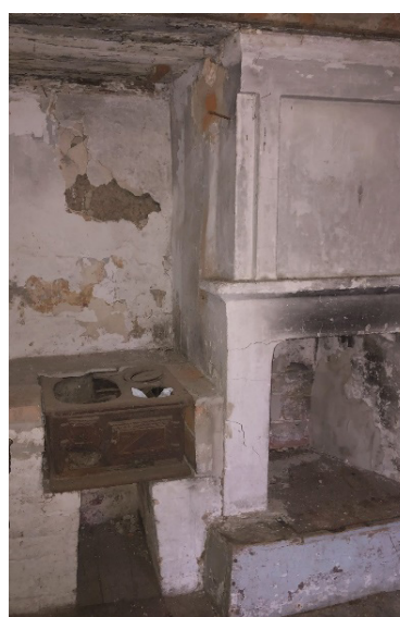
Figur 8. Spis 1, från vänstersida, där det syns att den är inmurad i murstocken.
