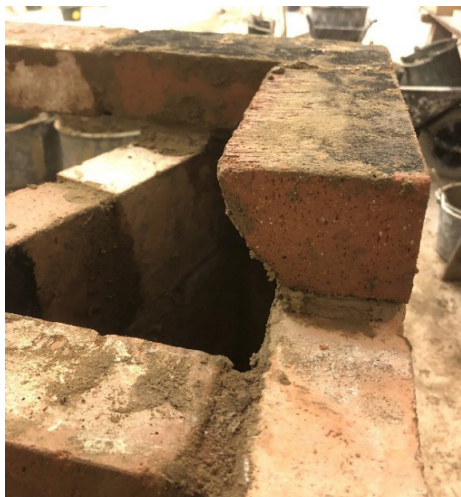
Figur 17. Det första liggskiftet. De stenar som kragas ut över rökkanalerna har huggits i underkant.
