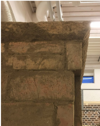
Figur 30. Sett från sidan. Ornamentet murat på samma skift som spjällbotten. Kronan muras över.
