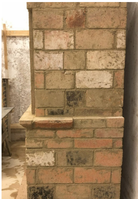
Figur 10. Övre och nedre livets förband sett från sidan.
