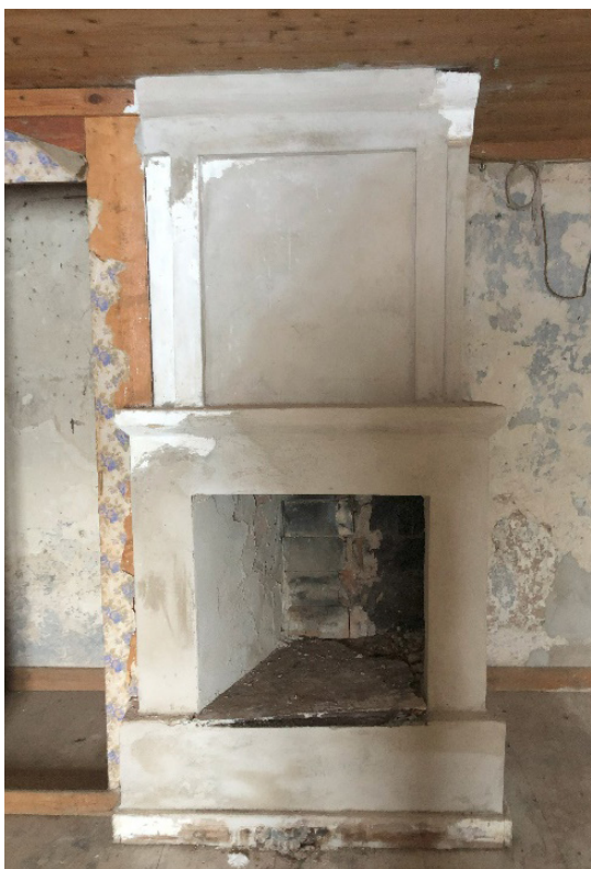
Figur 9. Spis 2. Eldstadens ena vägg saknas vilket gjorde det möjligt att se insidan lite bättre än på Spis 1.
