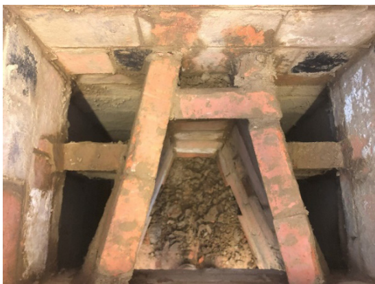
Figur 26. På 7:e skiftet lutas skiljeväggen och bakvägg framåt. Mellanväggarna lutas inåt och konformen börjar här bli rektangulär.
