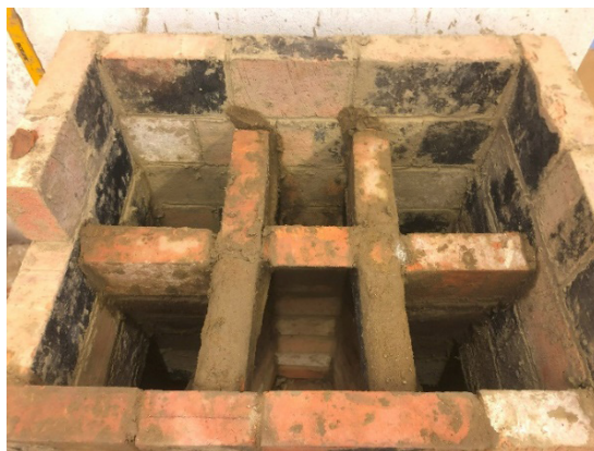
Figur 27. På 8:e skiftet möts eldstadens bakvägg och skiljeväggen 190 mm från ytterväggens innerkant. Nu är mellanväggarna rätats upp och blivit en rektangel.
