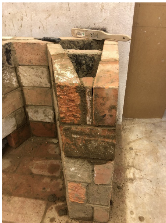
Figur 15. De tre nedre skiften murade så att stötfogen hamnar nästan över varandra. De två övre skiften ger ett starkare förband.
