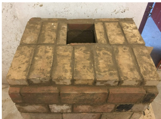
Figur 29. Spjällbotten, Stenarna vilar på skiljeväggen i mitten och ytterväggarnas kant
