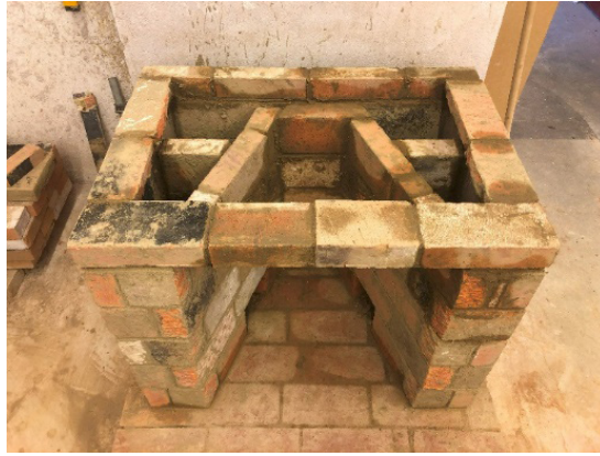
Figur 24. 6:e skiftet. De främre kanalernas area minskas drastiskt.
