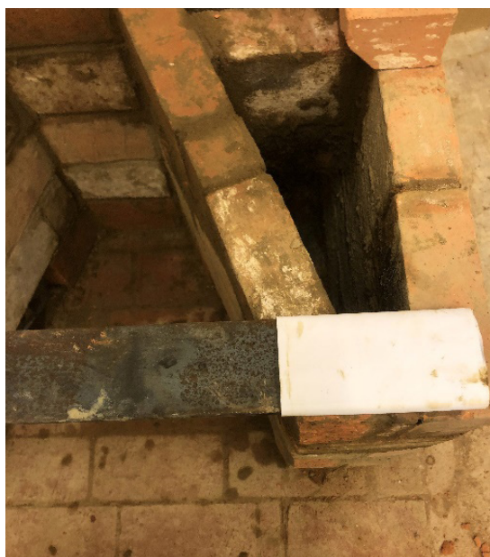
Figur 16. Plattjärn inlindat i papper vilar på spisens 5:e skift.
