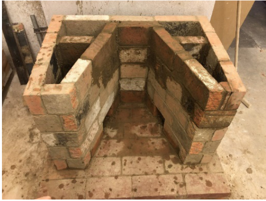
Figur 23. 5:e skiftet, skiftet innan inkrågning.
