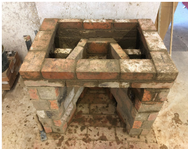
Figur 18. Spisens 6:e och 7:e skift är liggande och vid öppningen vilar de på ett plattjärn. Bakväggen består av byggmästarpettringar.
