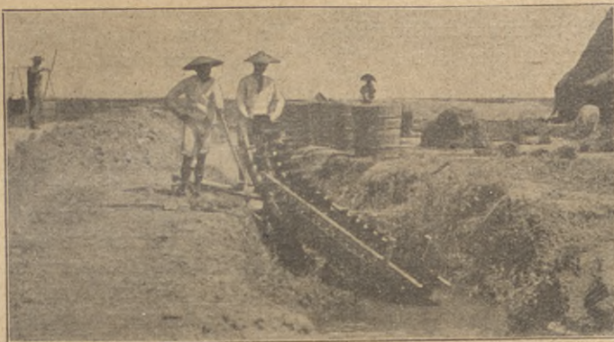
Vatten pumpas upp till ristälten och »tien» tvättas ur i de stora träkaren.
