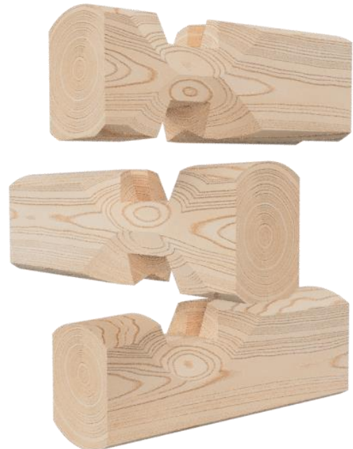
Figur 6. Del av ett timrat hörn där stockarna plockats isär.
