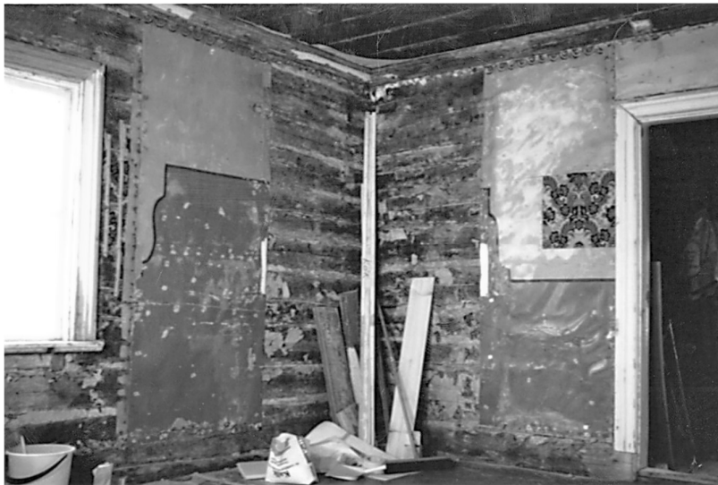
Figur 2. Uttorkad spännpapp återuppsatt i köket 1992 Planerad dokumentationsyta för äldre schablontapet intill dörrfoder
