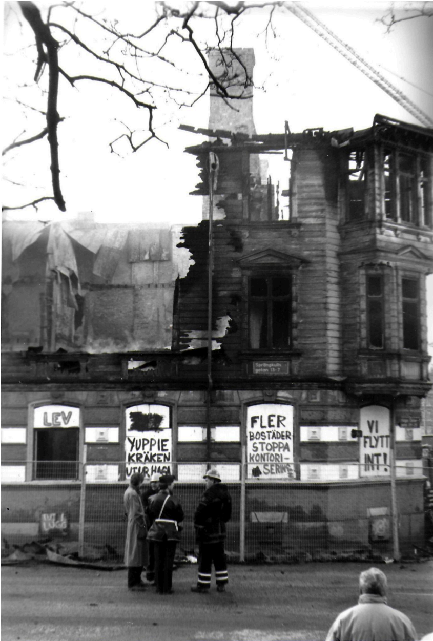
Figur 1. Bilden föreställer ett hus på Sprängkullsgatan i Göteborgs Haga som brann ner 1988. På huset syns skyltar där det står "YUPPIEKRÄKEN UT UR HAGA" och "FLER BOSTÄDER STOPPA KONTORISERINGEN." Detta visar på att folket i Haga 1988 redan då diskuterade gentrifieringsproblematik även om begreppet inte hade myntats i Sverige än. Foto: Peter Asp. Fotograferad År:1988.
