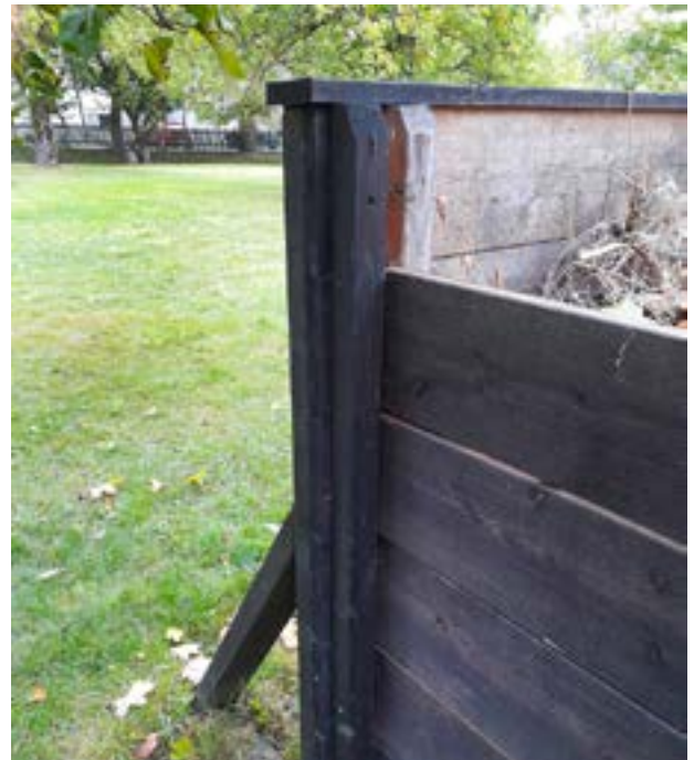
T h: I Göthlinska gårdens trädgård finns fem snickrade kompostfack som strukits med linolja. Brädorna i framkant kan lyftas i och ur i ett spår i en skiftesverksliknande konstruktion. Arkeologiska fynd av kompostbingar i stadsträdgårdar visar att konstruktionen mycket väl kan ligga nära en historiskt riktig lösning. Kompostfacken ger ett ordnat intryck, även under perioder då skötseln av komposten inte alltid hinns med som önskat.
