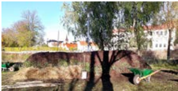
Den färdigbyggda kompostlimpan täcks med jord och slutligen ett ca 30 cm tjockt isolerande lager halm som läggs på nerifrån och upp.
