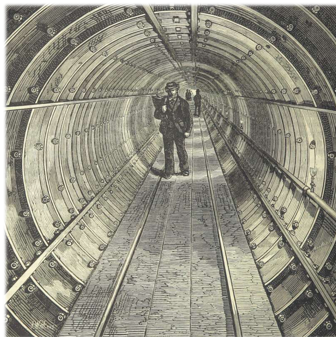
Fig 9. Tunnelbanebygge med tubsystem, år 1873.
