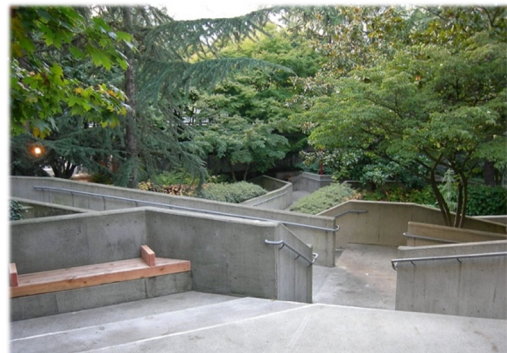
Fig 15. En vy inifrån Jim Ellis Freeway Park (2006).
