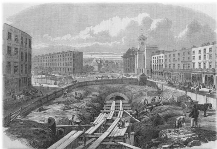
Fig 8. Tunnelbanebygge med den så kallade cut-and-covermetoden i London, år 1861.
