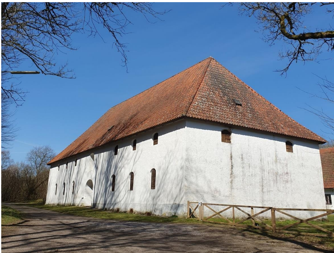
Figur 14: Magasinet som omnämns i breven den 23 december 1741 och 11 juni 1742, samt den byggnad som byggdes för de anställda i bakgrunden. Precis som Piper önskade murades det inte upp några skorstenar i magasinet.
