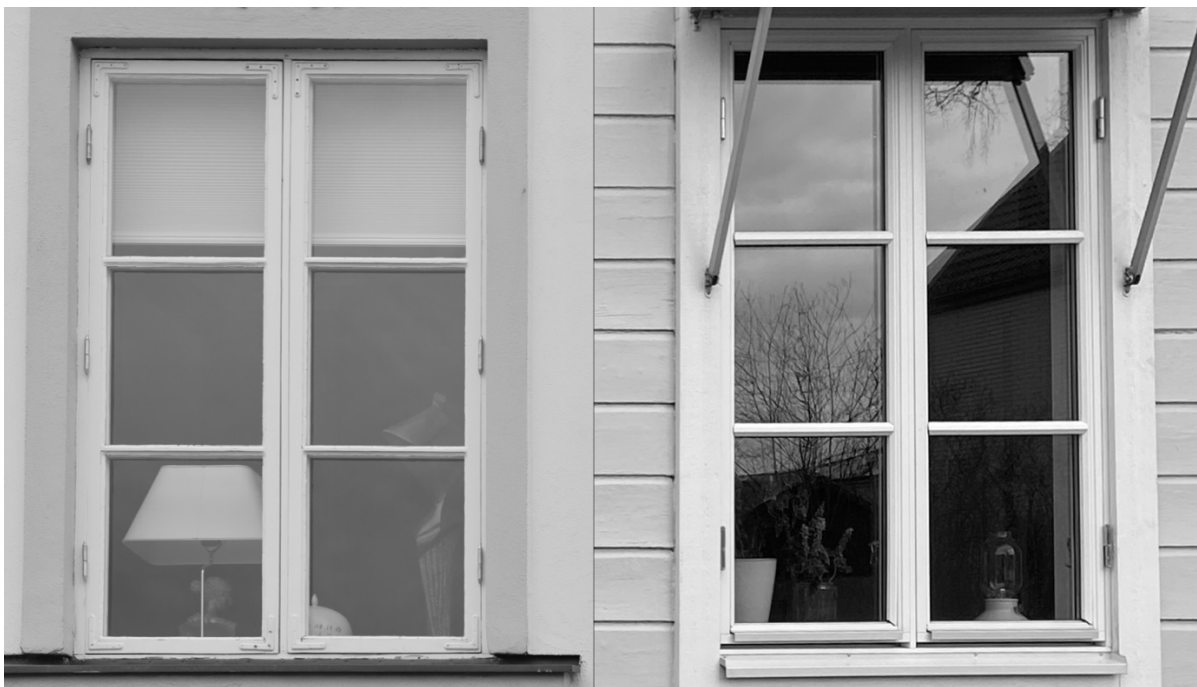
Figur 9. Till vänster det äldre välbevarade fönstret och till höger ett nyproducerat fönster. Omnämns som ”Fönster 4” i löptext.
