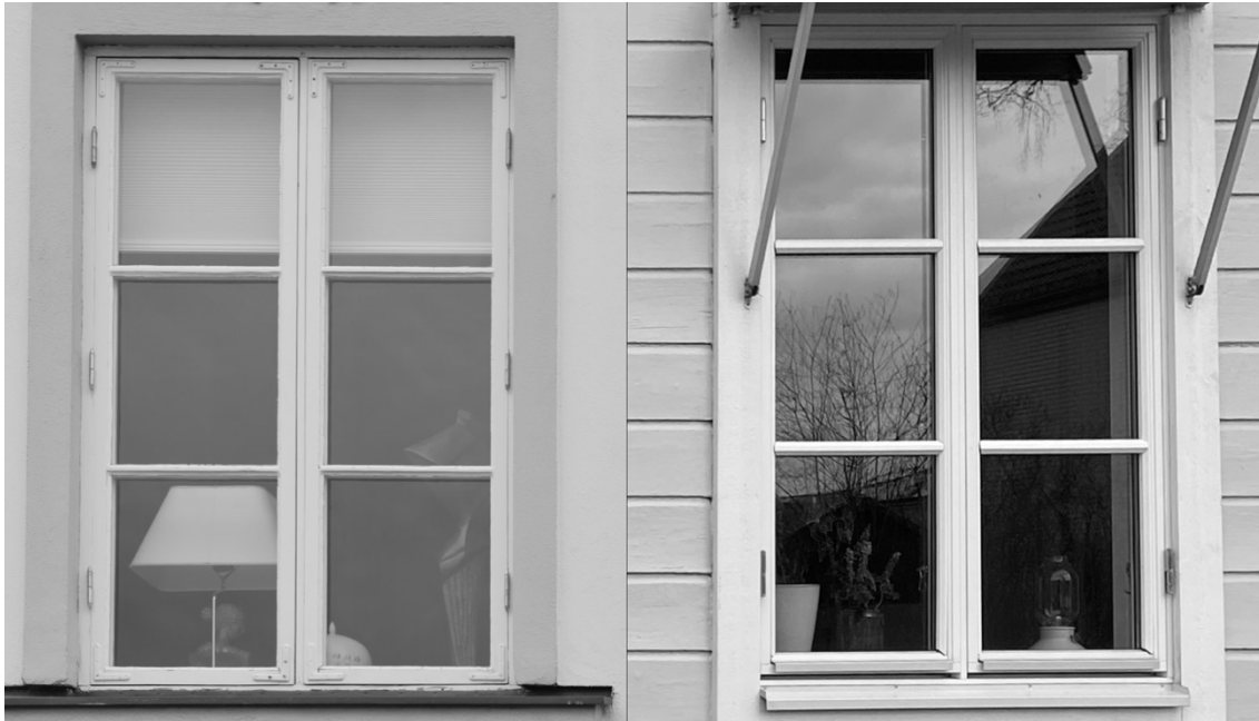
Figur 5. I löptexten omnämns detta fönsterpar som "Fönster 4". Det vänstra är det äldre välbevarade fönstret hemmahörande på byggnaden från 1920-talet och det högra är ett nyproducerat fönster.
