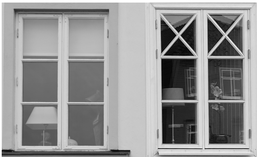
Figur 8. Till vänster det äldre välbevarade fönstret och till höger ett nyproducerat fönster. Omnämns som ”Fönster 3” i löptext.
