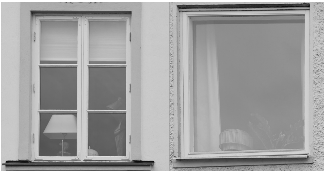
Figur 6. I löptexten omnämns detta fönsterpar som "Fönster 5". Det vänstra är det äldre välbevarade fönstret hemmahörande på byggnaden från 1920-talet och det högra är ett nyproducerat fönster.
