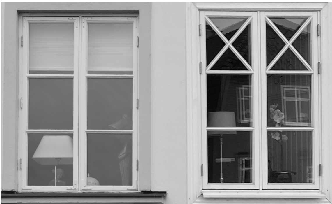
Figur 4. I löptexten omnämns detta fönsterpar som "Fönster 3". Det vänstra är det äldre välbevarade fönstret hemmahörande på byggnaden från 1920-talet och det vänstra är ett nyproducerat fönster.
