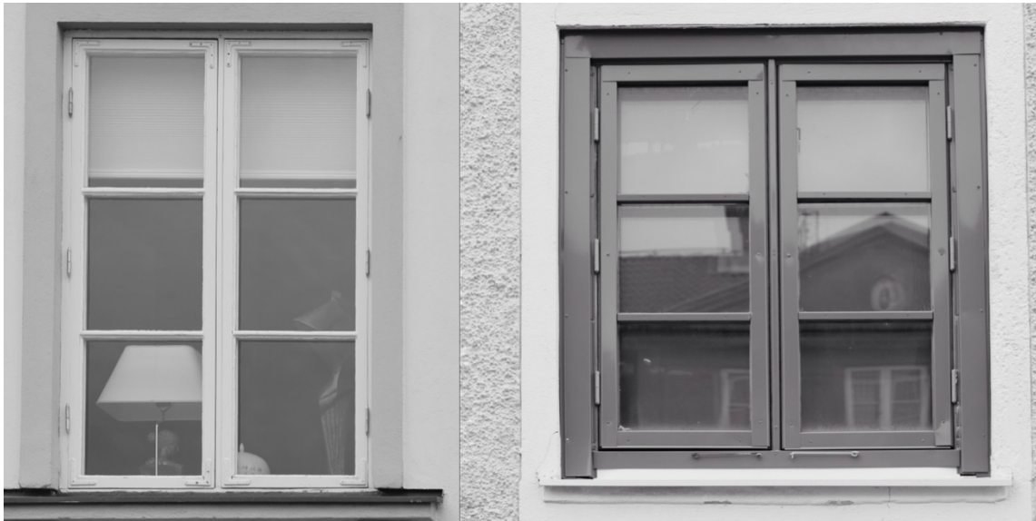
Figur 3. I löptexten omnämns detta fönsterpar som "Fönster 2". Det vänstra är det äldre välbevarade fönstret hemmahörande på byggnaden från 1920-talet och det högra är ett nyproducerat fönster.
