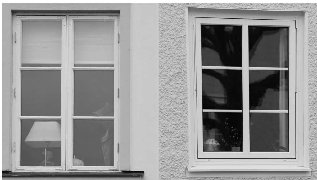
Figur 2. I löptexten omnämns detta fönsterpar som "Fönster 1". Det vänstra är det äldre välbevarade fönstret hemmahörande på byggnaden från 1920-talet och det högra är ett nyproducerat fönster.
