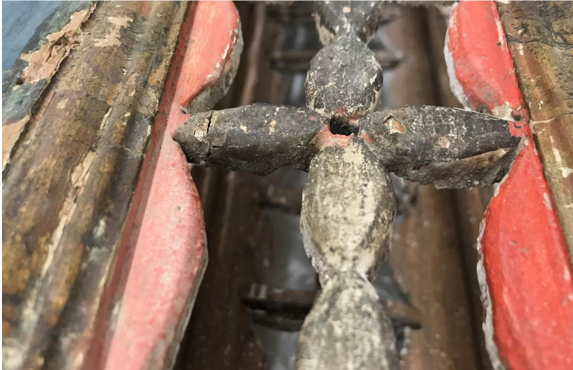
Figur 1 - Detaljbild från obelisk tillhörande Svanshals Kyrka. På bildens högra sida syns ett rött parti utan blinderingskador. Motsvarande parti på vänster sida visar upp en kraftig blindering. 1
