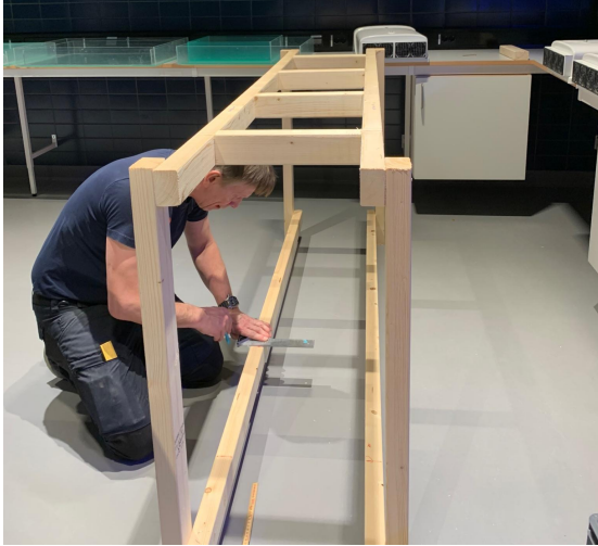
Bild 1. Byggandet av ställningen
