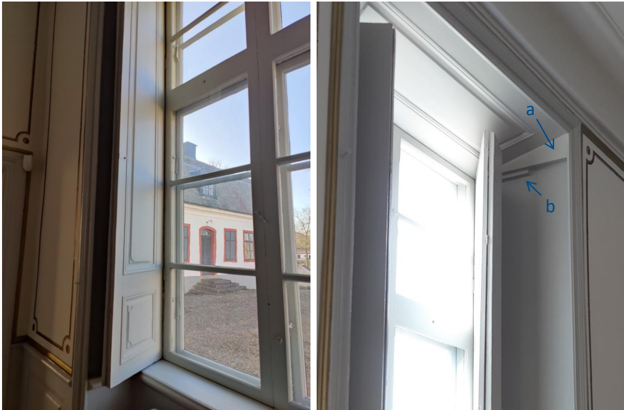
Figur 25 Fönsterluckor i olika lägen. T. h. Inuti smyglådan. Upptill a. passbiten b. distanskloss
