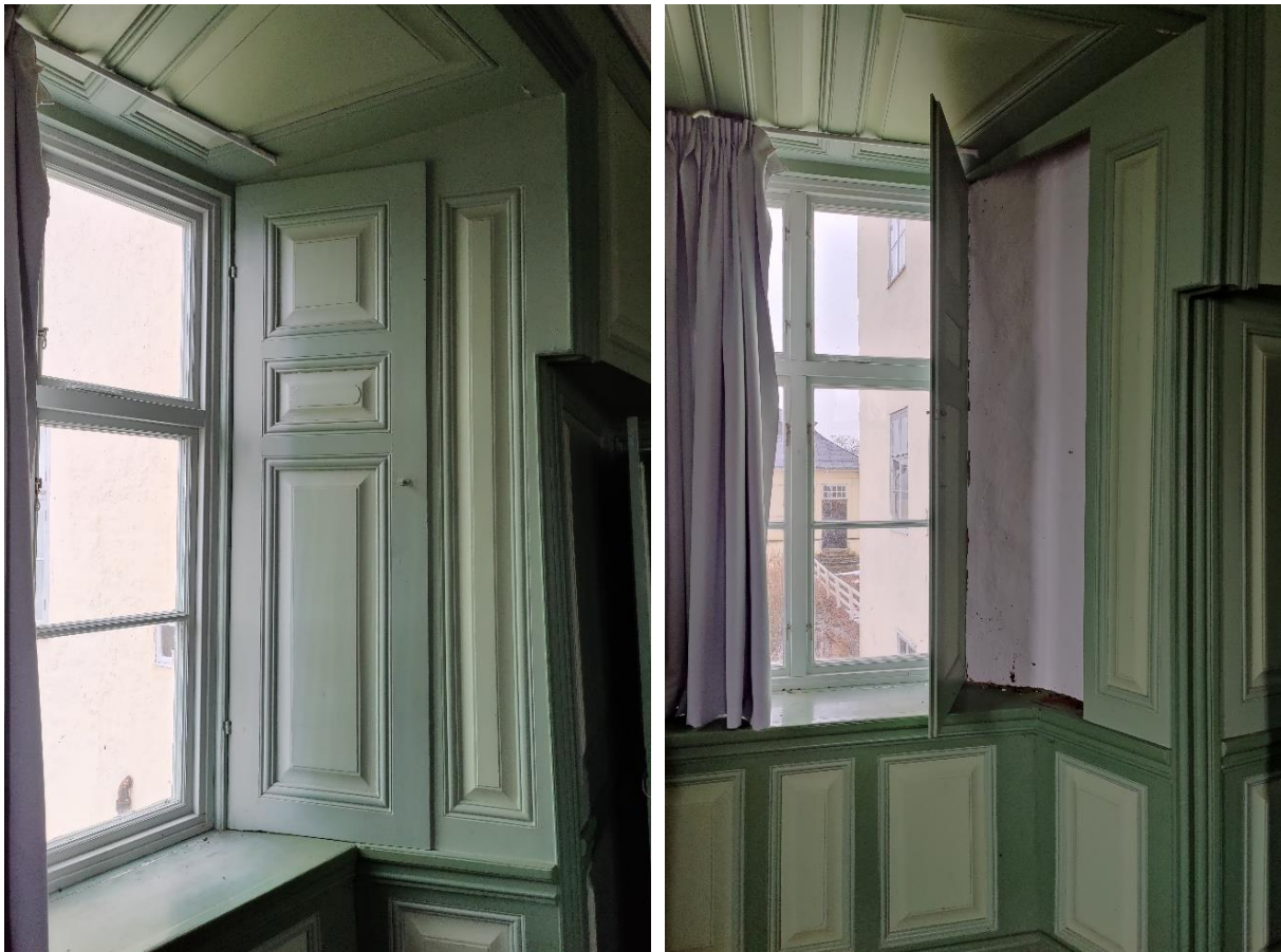
Figur 26 T. v. Fönsterlucka införd i smyglådan. T. h. Öppnad lucka med insyn i smyglådan
