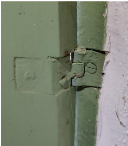
Figur 28 T. v. L-format gångjärn mellan karm och lucka.
