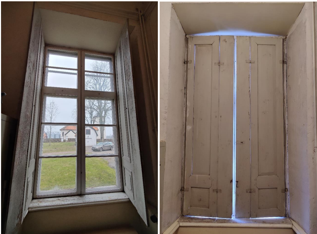
Figur 15 T. v. Fönsterluckorna i öppet läge. T. h. Fönsterluckorna i stängt läge
