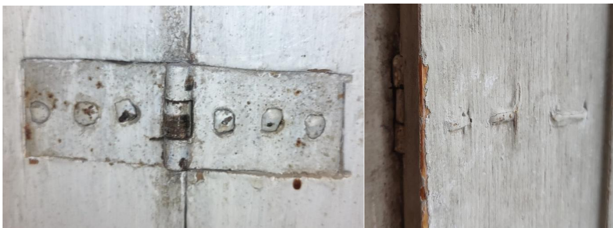
Figur 19 T. v. Ledgångjärn mellan lucka och klaff monterat på luckans baksida.
