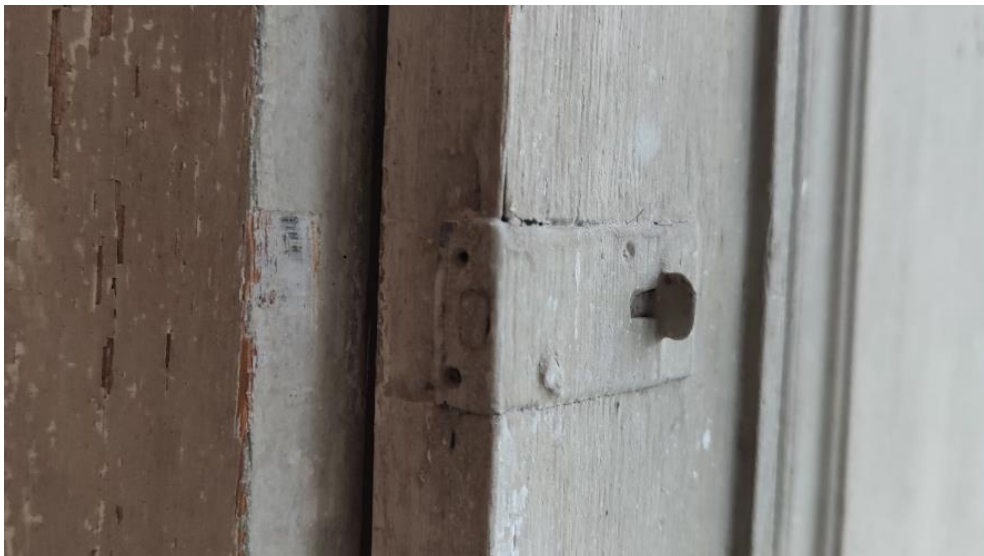
Figur 21 Skjutregel på primära luckan. Denna hade använts för att fästa luckan i smyglådan om det fanns en sådan.
