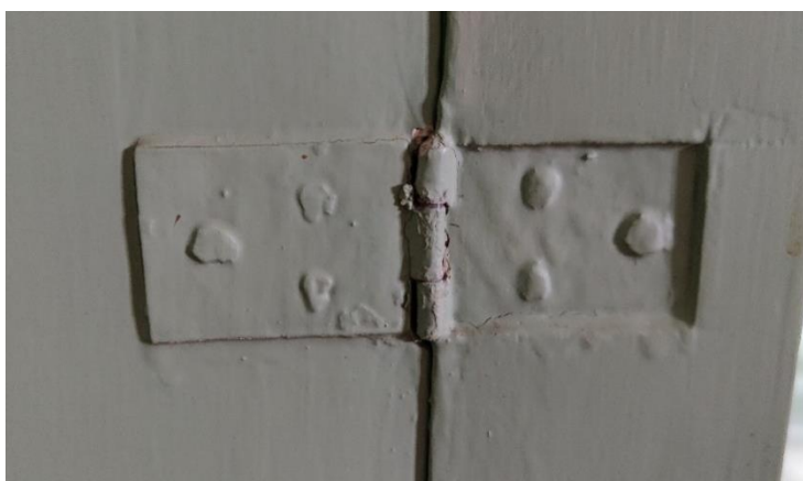
Figur 29 T. v. Ledgångjärn mellan lucka och klaff. Lägga märke till hur ena bladet är monterat direkt på träytan och det andra bladet är försänkt.
