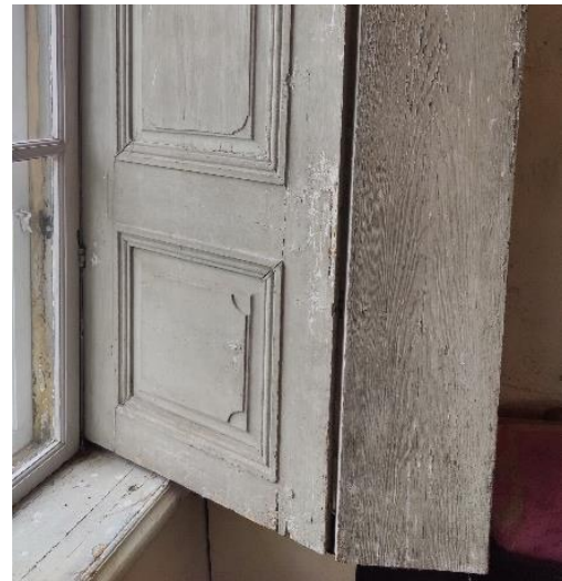
Figur 16 Detalj på höger lucka och klaff. Lägg märke till fyllningarnas nupna hörn.
