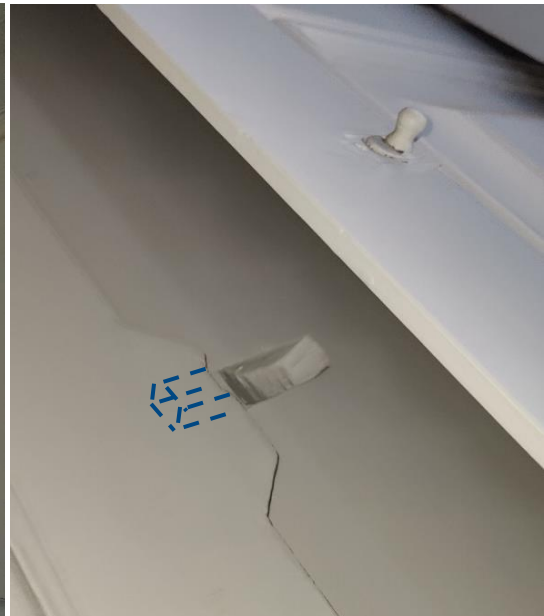
Figur 33 Insida fönsterlåda. Streckad linje visar det hål regeln låses fast i.
