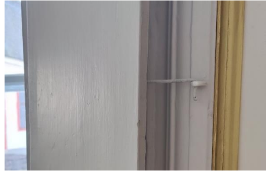
Figur 24 Hasp och ögla som kvarhåller luckan i öppet läge.
