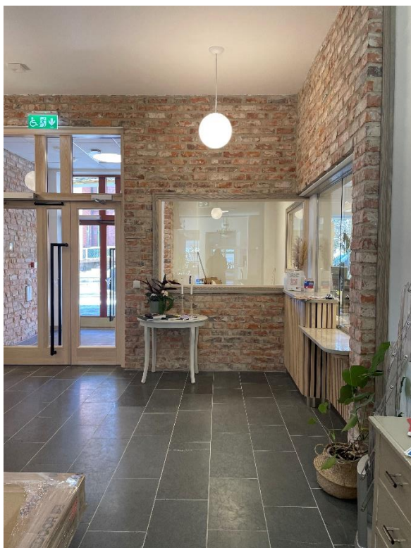
Fig. 14. Återbrukat tegel, fönster och armatur i ett nybyggt församlingshem. Delarna och materialen demonterades från det äldre församlingshemmet på platsen, Tidaholms pastorat.
