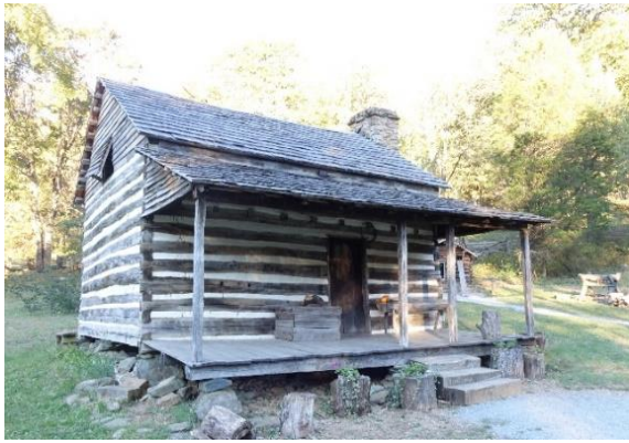
Figur 62 och 63. En timrad stuga bevarad på friluftsmuseet i Williamsburg, Virginia med tätning av lera mellan stockarna. Foto: Mattias Hallgren. Till höger står Edvin Karlsson från Kampedalen i Nössemark framför sitt nya hus i USA. I bakgrunden skimtar den knuttimrade stugan han byggde först. Bilden illustrerar den "bostadskarriär" som många gjorde på sina gårdar. Nössemark i ord och bild s 213.
