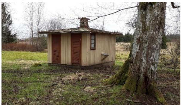
Utedasset med ventilationshuv på taket. Foto MOW 2020
