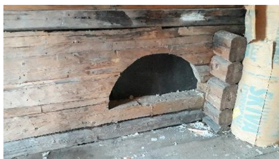
Spår av det äldre husets timmerstomme och lunettformade halvåvningsfönster. Foto MOW 2019
