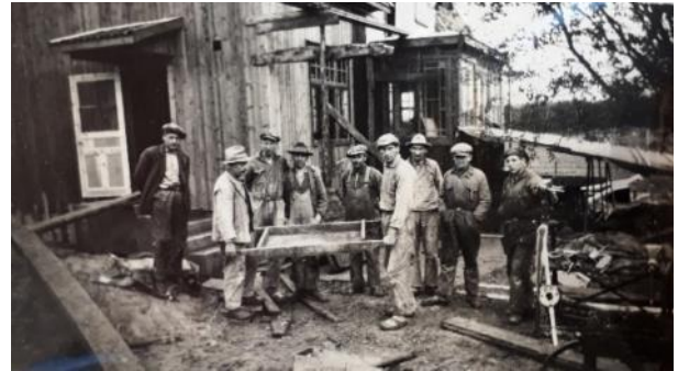
Arbetslaget under uppförandet av nya huset. Foto lånat av fastighetsägaren.
