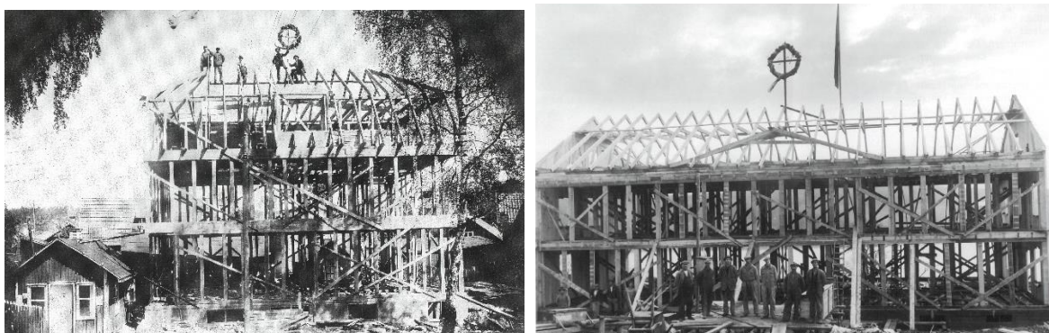
Figur 107 och 108. Exempel på regelstommar i Bengtsfors. Till vänster August Pettersson husbygge 1924. Han var i USA på 1890-talet och drev sedan boskapshandel och charkuteriverksamhet i Bengtsfors. Till höger Skåpafors herrgård som byggdes 1933-34. I alla fall det sistnämnda men sannolikt även det första är byggt av Severin Jonasson, byggmästare i Bengtsfors med omnejd. Josefsson s 94
