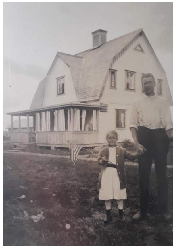
Norma och Fridolf vid den nybyggda verandan 1923. Foto lånat av fastighetsägaren.
