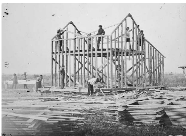
Figur 22 och 23. Hus i regelverk under konstruktion, Omaha Reservation, Nebraska, 1877. Foto: William Henry Jackson. Till höger en illustration av ett hus i Forusquare-modell under konstruktion som kunde beställas via postorder från Sears, Roebuck and Company 1926, Duchscherer 2005 s 5.
