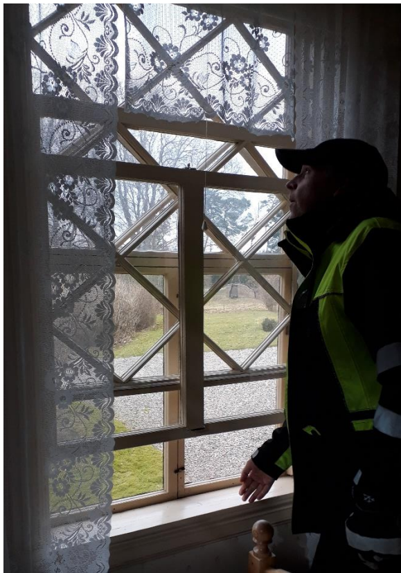
Figur 115. Fastighetsägaren Henrik Ohlsson demonstrerar skjutfönstren på Ässet. På utsidan syns den extra båge som monteras på utsidan vintertid. Foto MOW
