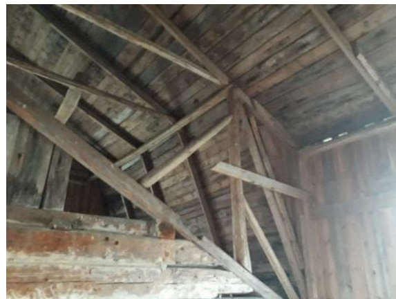
Kallvind med synlig takkonstruktion. Foto MOW 2019
