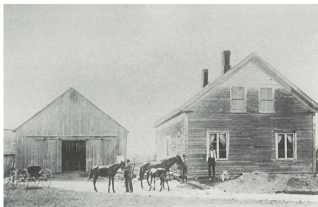
Figur 74. Bostadshus med såväl amerikanska skjutfönster "två över två" och "svenska" på gångjärn. Nilsson 1975 s 204
