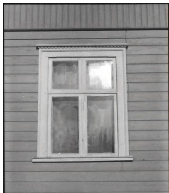
Detalj med liggande panel samt fönster med dekorerat överstycke. Från Kulturhistorisk byggnadsinventering nr 31. Foto: Margareta Hallin 1982.
