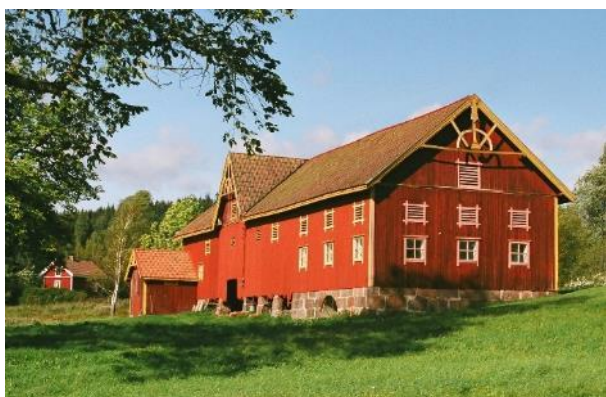
Ladugården byggdes 1926 av snickarna Sven Petter Jonasson från Olsbyn och hans brorson Verner Karlsson. Odenbring Widmark s 147
