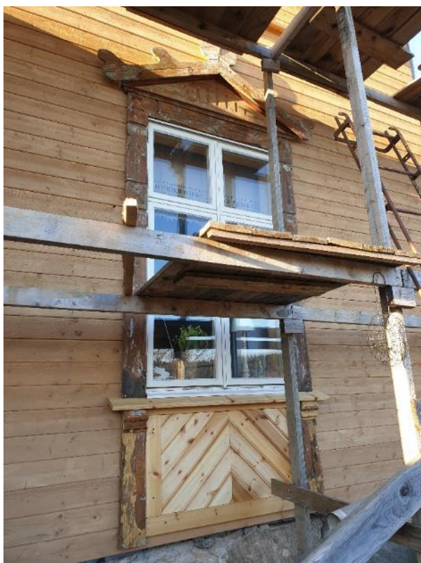
Fasaden med liggande spontad panel och de speciella fönsteromfattningarna under renovering. Foto fastighetsägaren.
