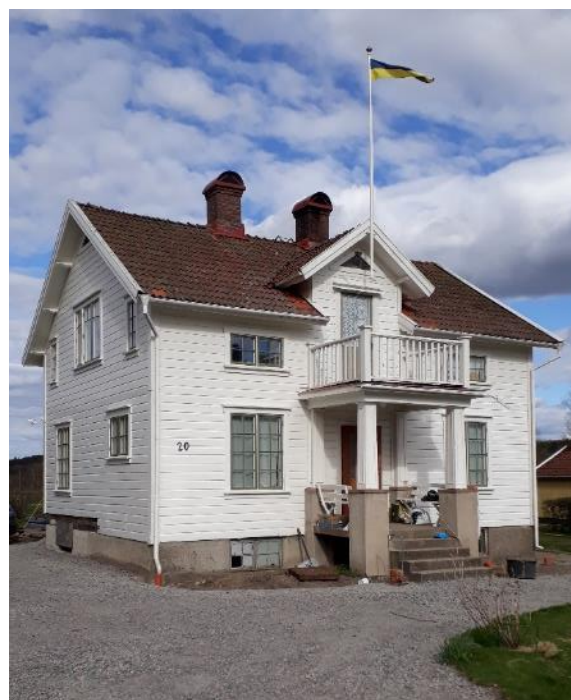
Virginia med återställda fönster. Flaggstången är original. Foto MOW 2020.
