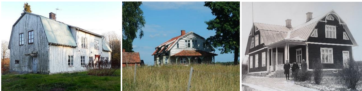
Figur 85, 86 och 87. Kleven, Dykällan och Nilsbyn. Foto MOW 2019 samt lån av fast.äg. Se också Bilaga s 31, 46 och 14.
