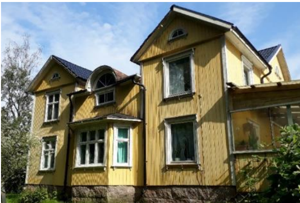
Huset bakre fasad med tillbyggnader. Foto MOW 2019
