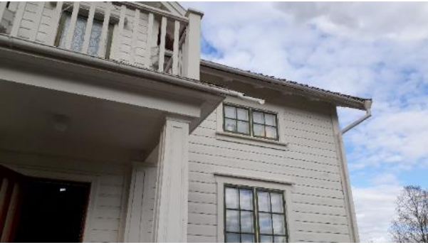
Detalj av verandan med de fyrkantiga pelarna, och smäcker hängränna med liten utkastare. Foto MOW 2020.
