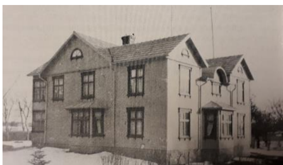
Efter om- och tillbyggnad. Foto ur Brålandaboken II.
