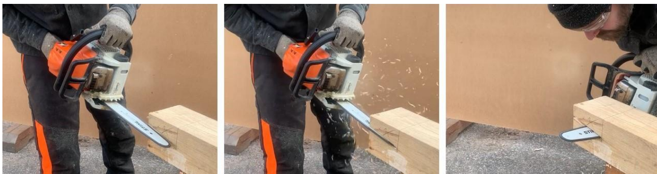
Figur 33. Hörnskarv med sned skärning variant 2, snitt ett, två och tre. (Alkdal 2023)
