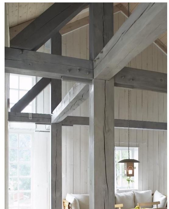
Figur 47. Synliga stolpverkskonstruktioner i nybyggt hus. Exempel på estetiskt snygga träförbindningar utförda av Johannes Kästel. (Stellan Herner u.å.)
