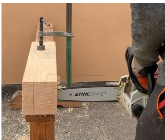
Figur 8. Tapp variant 1, snitt två. (Alkdal 2023)
