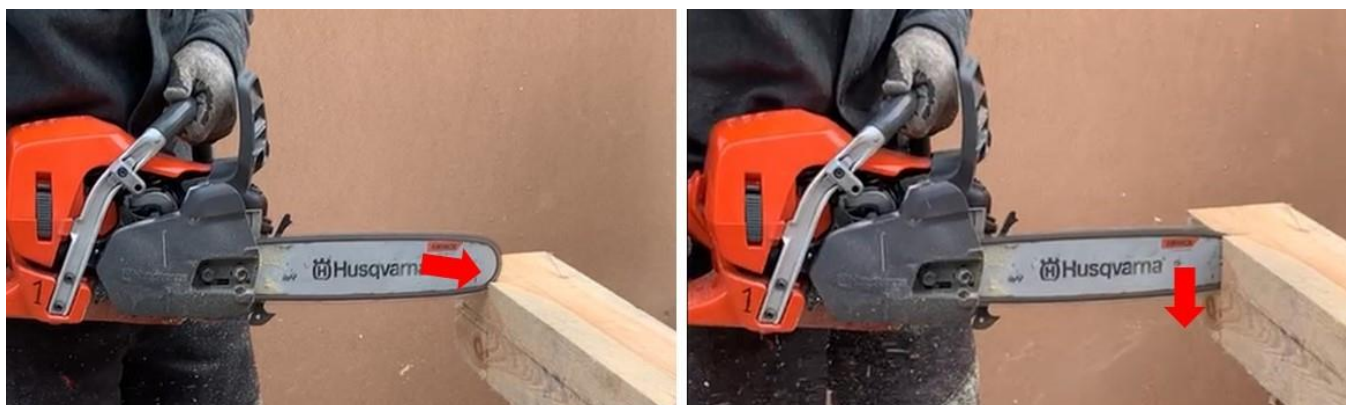
Figur 17. Laxstjärtstapp variant 1, snitt ett och två. (Alkdal 2023)
