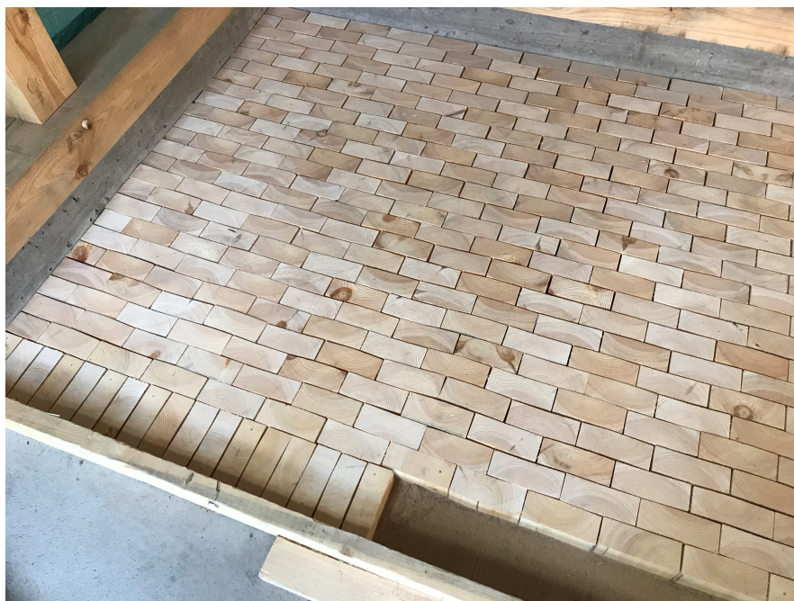
Figur 12. Fotografi på kubbgolvet under anläggning av den sista stående raden. Förutom löpförbanden går även det konvex - konkava mönstret att identifiera.
