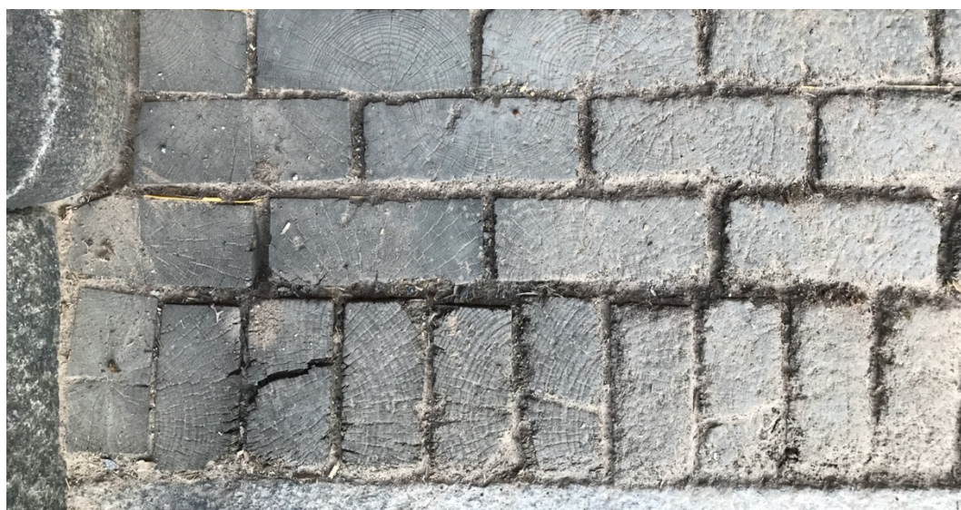
Figur 6. Fotografiet visar på kubbens materialurtag där kärnved, sprickor, märe samt kvist förekommer. Från vänster till höger illustreras även de olika förslitningsgraderna, där de längst till vänster är minst nötta medan man successivt till höger kan se hur kubben blir mer och mer tilltryckt.
