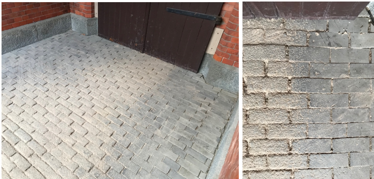
Figur 5. Fotografierna visar kubbgolvet olika grader av slitage.
