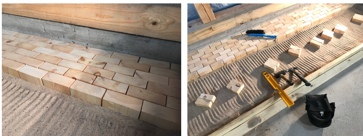
Figur 11. Fotografierna visar kubbgolvets uppbyggnad under hantverksförsöket.
