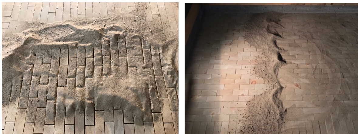
Figur 13. Fotografier av kubbgolvet fogfyllning. Den vänstra bilden visar den första fogfyllningen och den högra bilden visar den andra fogfyllningen.
