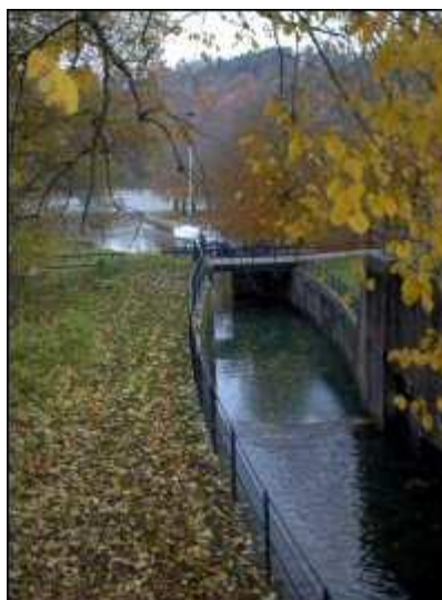
Figur 6: 1800-års slussar i Trollhättan, nedre delen vid Åkersvass.
