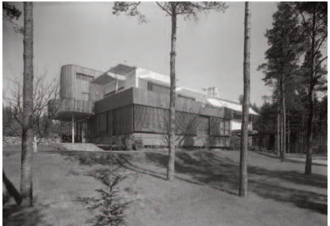
Villa Mairea: fasaden mot sydväst.
