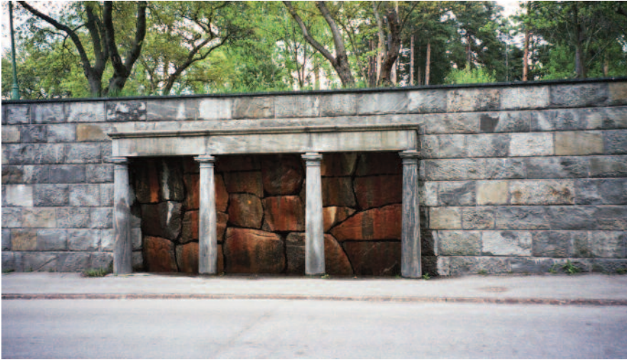
Den gråtande muren.
