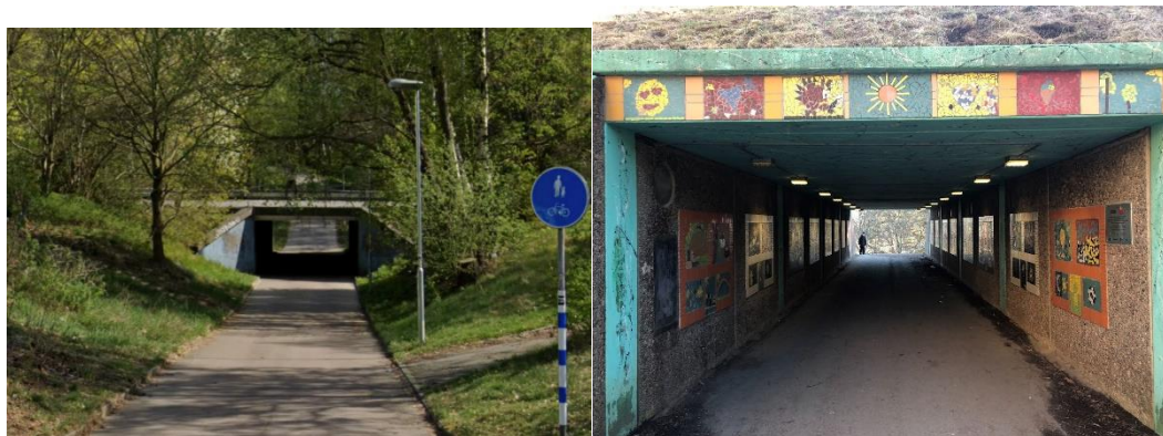
Gångtunneln vid Blidvädersgatan och gångtunneln vid Stackmolnsgatan/Södra Fjädermolnsgatan.
