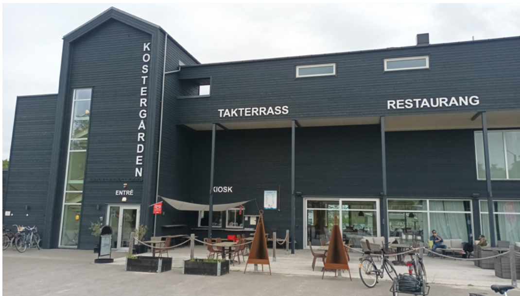
Figur 29. Kostergården, Sydoster. Semesteranläggningen är ett exempel som uppmärksammas av flertalet informanter från Kosters Samhällsförening. Informanterna upplever att själva utformandet av byggnaden har, som det uttryckts; ”släppts väldigt fritt” kopplat till ett rimligt antikvariskt perspektiv i yttrandet av ärendet. I remissutlåtandet görs bedömningen att ”förslaget inte kommer innebära menlig skada på miljöns kulturhistoriska kvaliteter och har utifrån lokalisering och gestaltning inget att erinra mot förslaget”. (Bohusläns Museum, Va535-2014)
