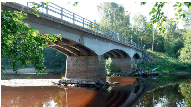
Figur 5.16. En bro av armerad betong vid Stavreviken i Medelpad. Konstruktionen är möjlig enbart på grund av att konsolbalkarna är armerade och klarar av lasterna från mötande konstruktionsdelar. Foto: Sven Olof Ahlberg, 2021.
