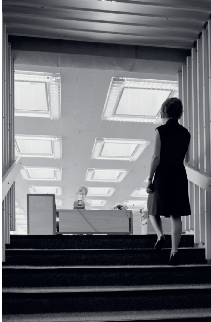
Figur 4.8. Det manshöga gallerverket svävar till synes fritt i luften samtidigt som den lätta glasbyggnaden är upphängd i den. Foto: Poul Petersern/Realdania By & Byg, 1960-tal.
