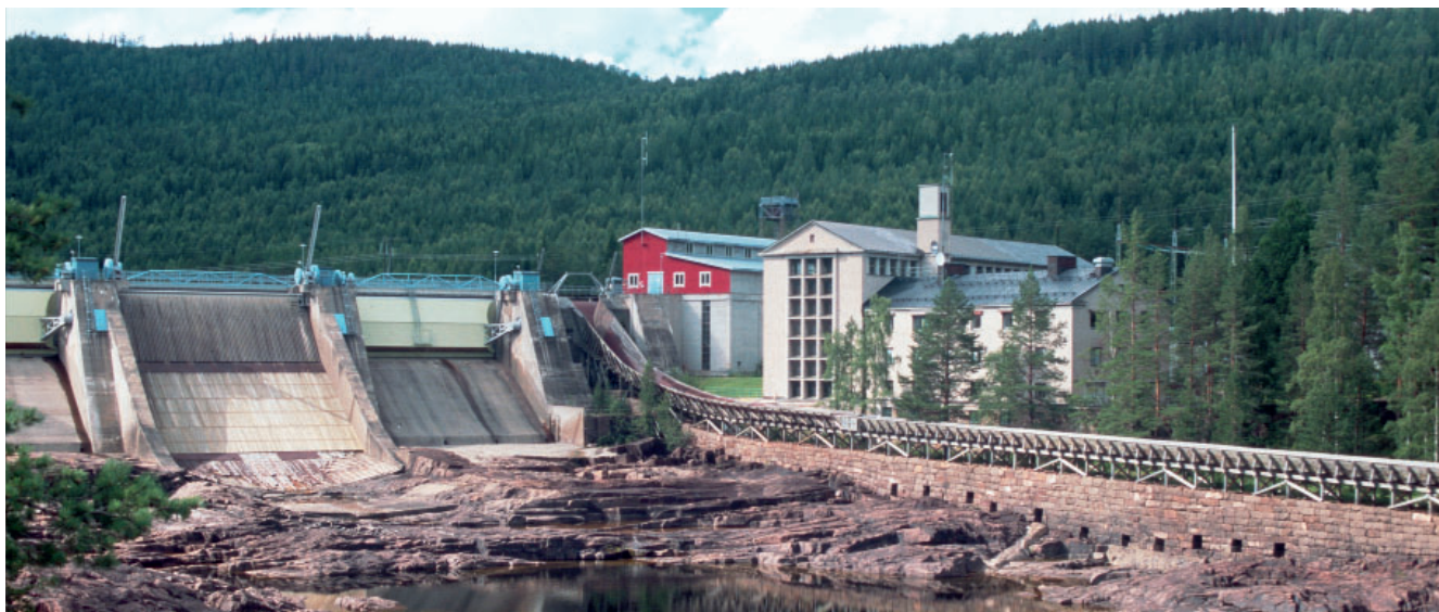
Figur 3.11. Krångede kraftverk i Indalsälven byggdes 1933-1936. Betongen är gjord av pansarcement som gav en ljusare beigeartad kulör. Foto: Sven Olof Ahlberg.
