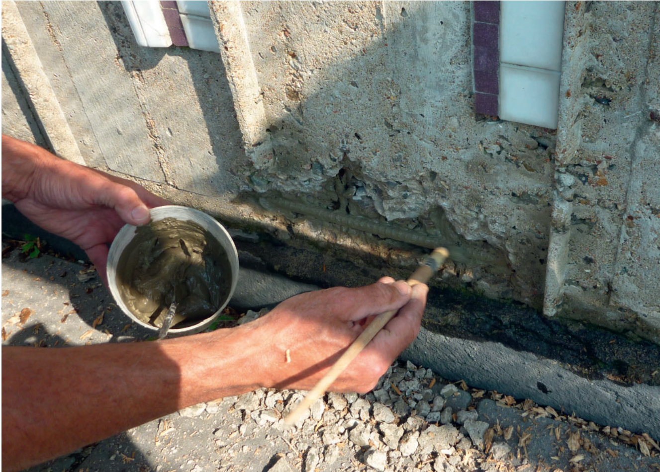
Figur 9.26. Väggregeliefens all synliga armering rostskyddsbehandlades innan skadorna i betongen reparerades. Foto: Stefan Holmgren.
