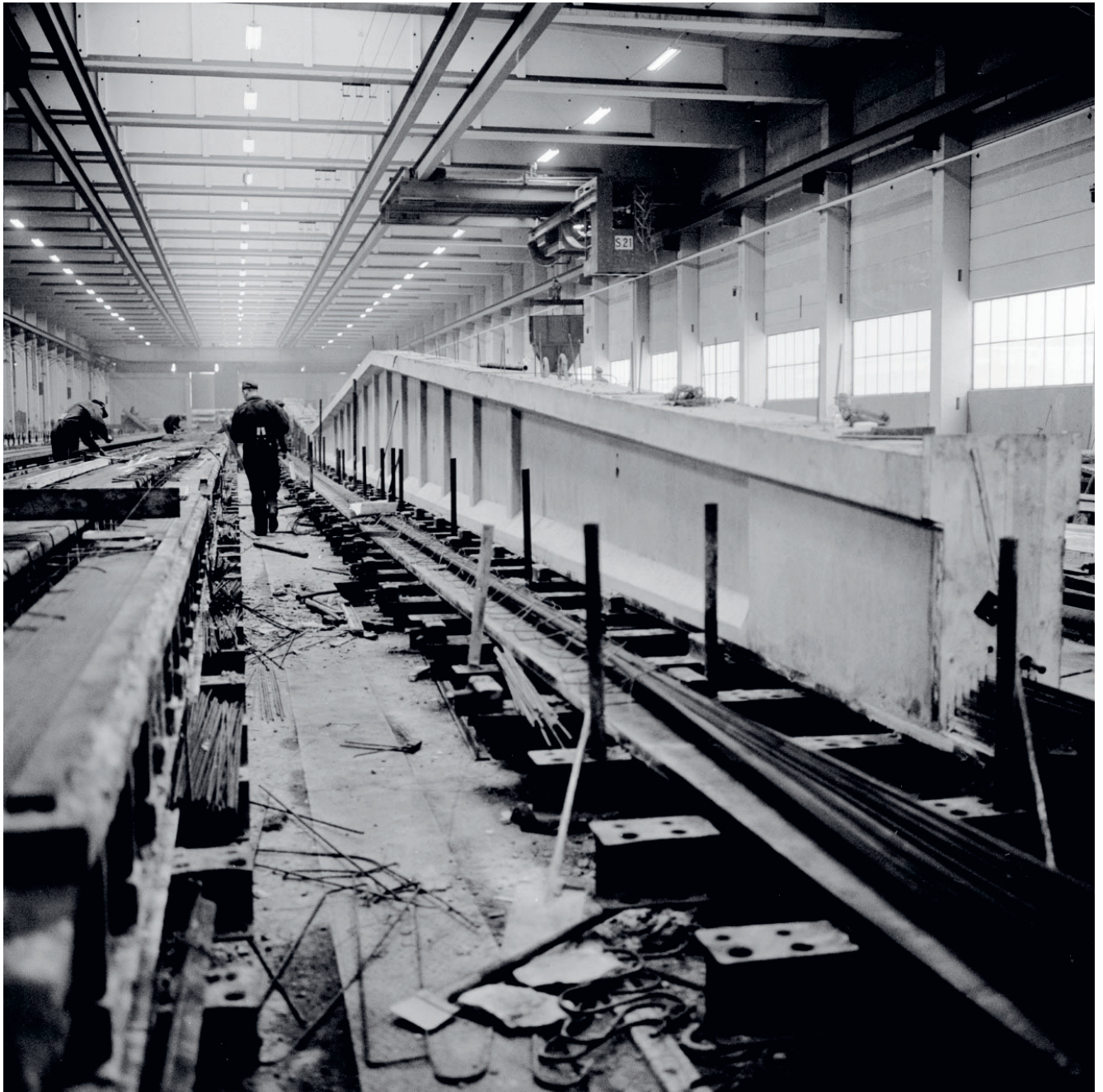
Figur 2.20. Interiör från tillverkningen av spännarmerade takstolsbalkar vid en av Strängbetongs fabriker i Veddige. Notera hur gjuthallens stomme är uppförd med liknande balkar och pelare. Den färdiga takstolen har lyfts ur formbädden (t.v. i bild) och på golvet ligger en bunt armeringsstål redo för nästa takstol. I den färdiggjutna konstruktionen syns hur spännstålen sticker ut längst ned på balken i en A-liknande form. Foto: John Hylterskog, SJ Press 1963. Järnvägmuseets samlingar, JvmKBDB12743:01. Digitaltmuseum.
