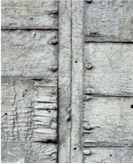
Figur 8.4. Två exempel på betongytor. Till vänster avtryck av träform inklusive spikhuvuden. Till höger en fasad med frilagd grov ballast. Foto: Urs Müller.
