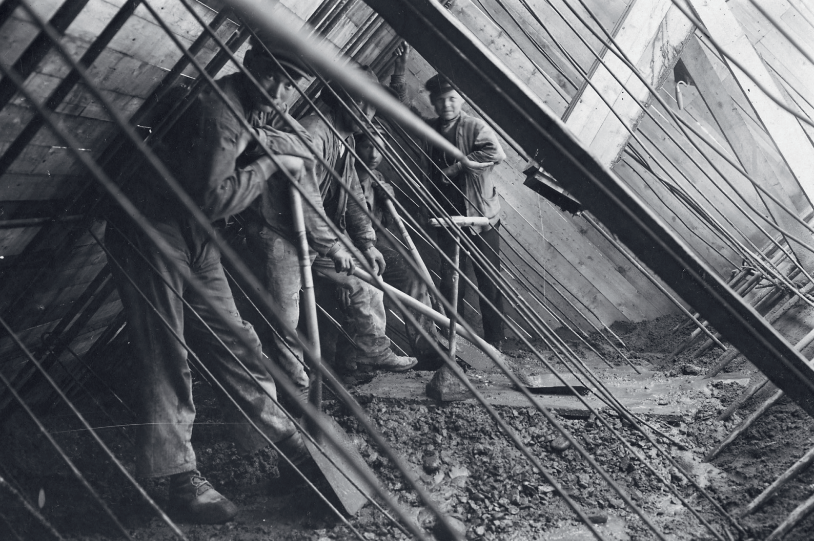
Figur 2.22. Fotografen har bemödat sig med att krypa in i gjutformen för Tallbergbron över Öre älv då gjutningen av stampbetongvalvet var i full gång. Bron stod klar 1919 och var då världens största betongvalvbro på normalspårig järnväg. Idag är bron ett statligt byggnadsminne. Foto: Okänd fotograf. Järnvägmuseets samlingar, JvmK-DAE10345, Digitaltmuseum.
