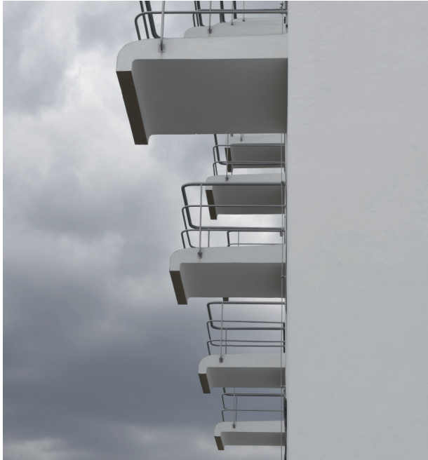
Figur 5.15. Balkonger med konsolerande betongplattor vid Bauhausskolan i Dessau. Foto: Sven Olof Ahlberg, 2021.
