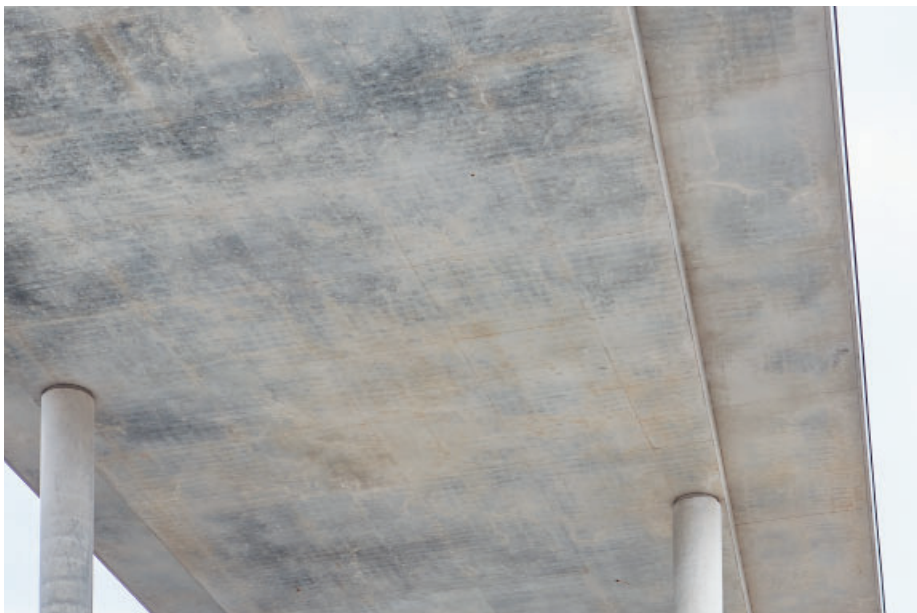
Figur 7.37. Blåaktiga områden på en annars ljusgrå yta är exempel på missfärgning. Foto: Urs Müller.
