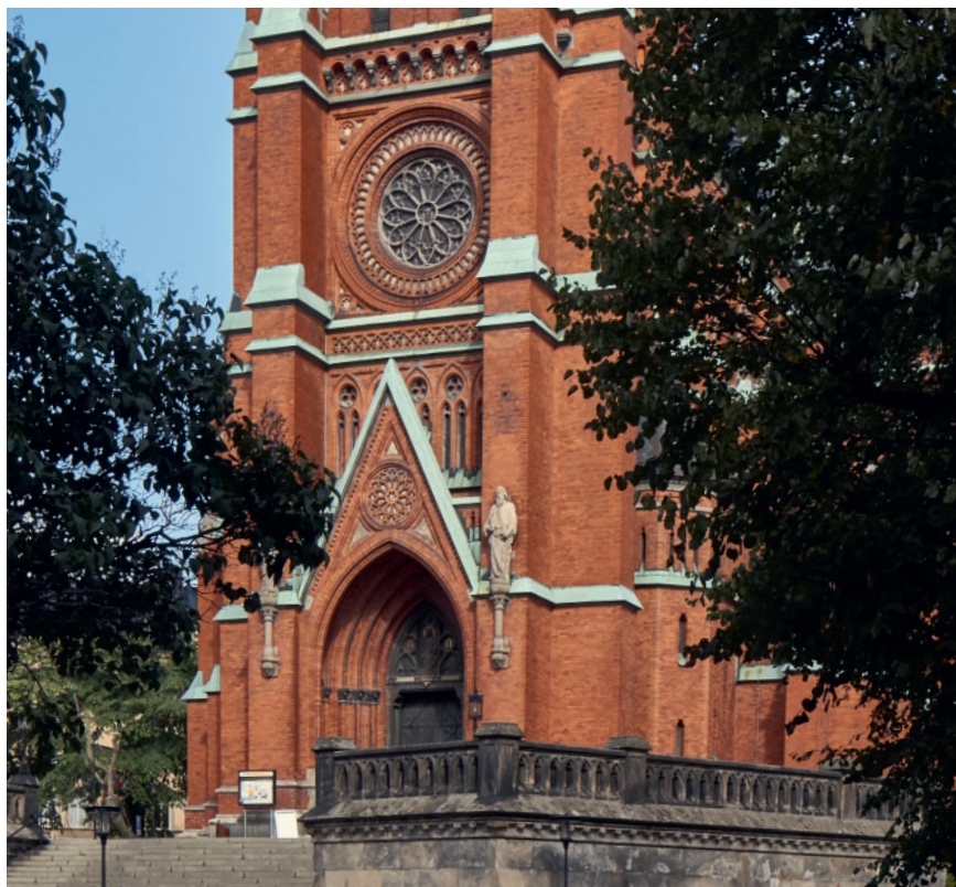
Figur 4.19. S:t Johannes kyrka i Stockholm uppfördes 1883-1890 med många byggnadsdetaljer av oarmerad stampbetong. Foto: Fredric Boukari.
