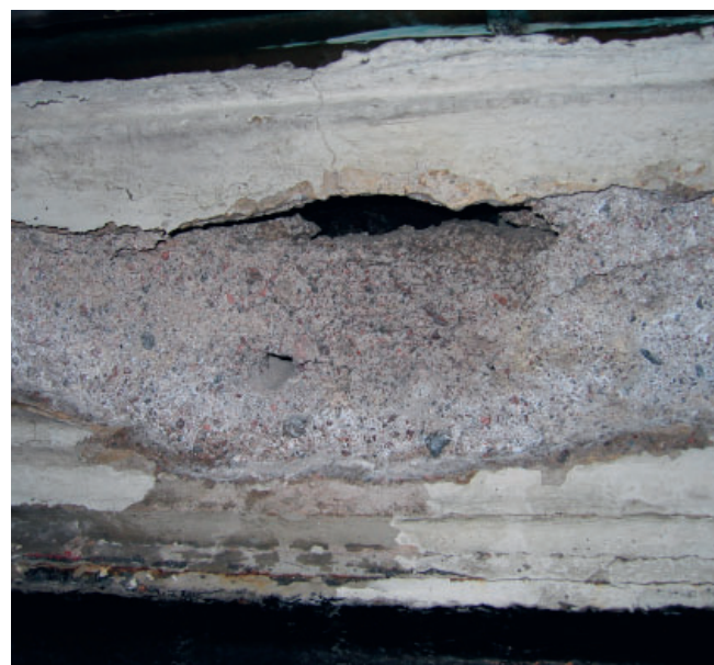
Figur 7.34. En gjuten balkongplatta där betong med aluminatcement använts (till vänster). Nedbrytning av bindemedlet på grund av omvandling av hydratfasen (till höger). Foto: Anders Thorsén.
