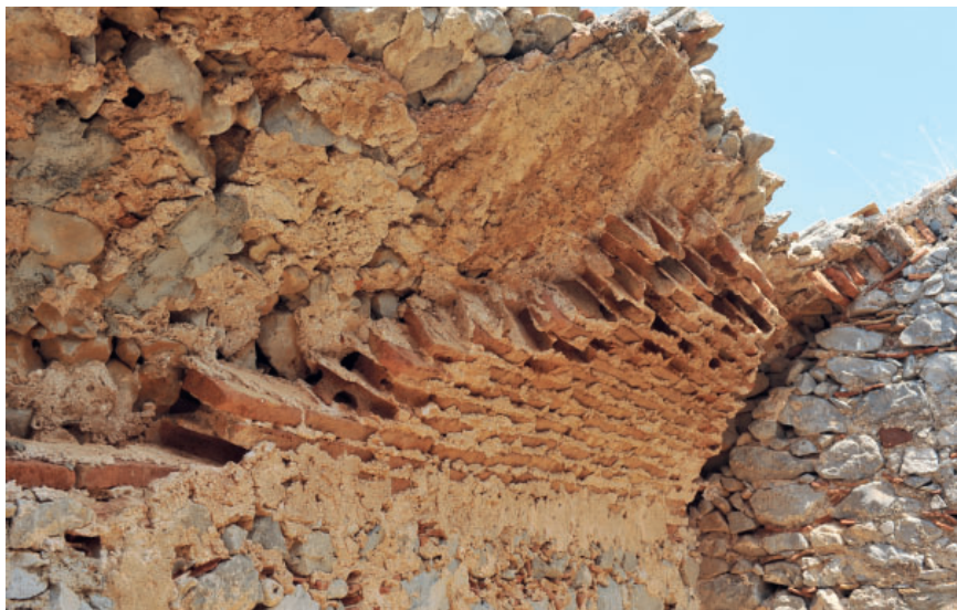
Figur 3.5. Resterna av romersk betong, opus caementicium , i en valvkonstruktion i Cefalu på Sicilien. Tegelvalvet användes som en kvar-sittande form för den ovanliggande betong-fyllningen. Bindemedlet i den antika betongen, bruket och putsen bestod av bränd kalk och pulveriserat material som innehöll kiselsyra, till exempel pulveriserat tegel eller vulkanaska, så kallad puzzolan. Foto: Sven Olof Ahlberg, 2012.
