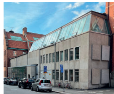
Figur: 9.5. HDKs utbyggnad från 1964 med fasad av prefabricerade betongelement. Foto: Stefan Holmgren.
