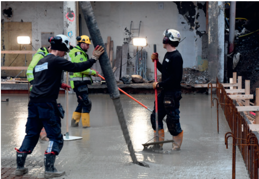
Figur 3.16. Gjutning av ett betongbjälklag kräver en ordenlig arbetsinsats med utportionering av betongen, avjämning, inmätning av höjder och slutlig justering av eventuella misstor. Foto: Sven Olof Ahlberg, 2020.
