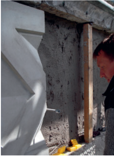
Figur 9.1. År 2009 restaurerades den nygotiska kyrkan i Grebbestad från 1892. Här monteras nygjutna betongsegment som utgör en dekorativ fris på tornet. Foto. Stefan Holmgren.
