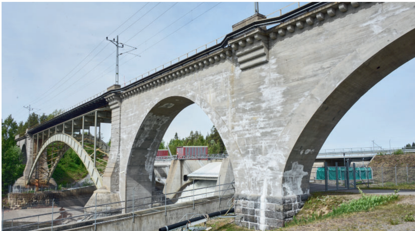
Figur 7.39. Järnvägsbron över Piteälven vid Sikfors. Bron är statligt byggnadsminne. Betongytan har fått en vit skorpa som huvudsakligen är karbonatiserad kalciumhydroxid som utlakats från betongen men även salter har påträffats. Foto: Sven Olof Ahlberg.
