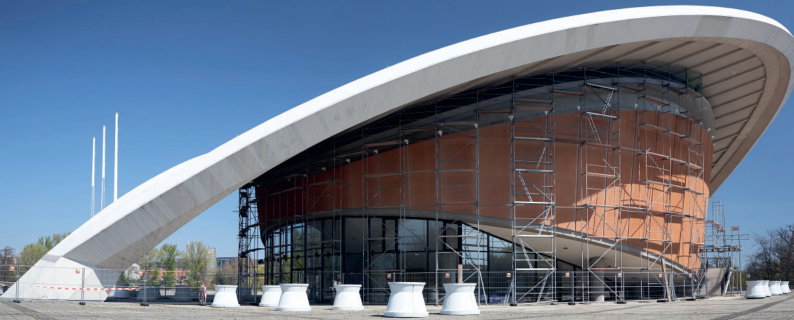
Figur 8.13. Kongresshallen Haus der Kulturen i Berlin har en stomme av förspänd armering som kollapsade 1980. För att fördröja korrosion av armeringen målades betongen med ett beläggningssystem som ska minska inträngning av syre, koldioxid och kloridjoner. Foto: Urs Müller.
