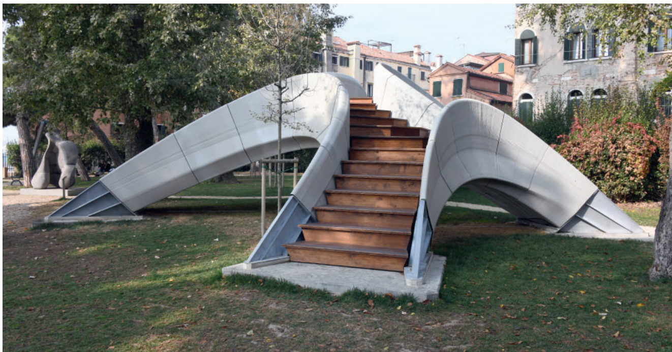
Figur 2.36. Striatibusbron i Venedig. Konstruktionen består av 3D-printade oarmerade betongelement som vilar mot anfangar av stål. Upplagen är förbundna med ett X av stålprofiler i marknivån, vilket tjänar som dragband och mothåll för tryckkrafterna. Foto: Sven Olof Ahlberg, 2021.
