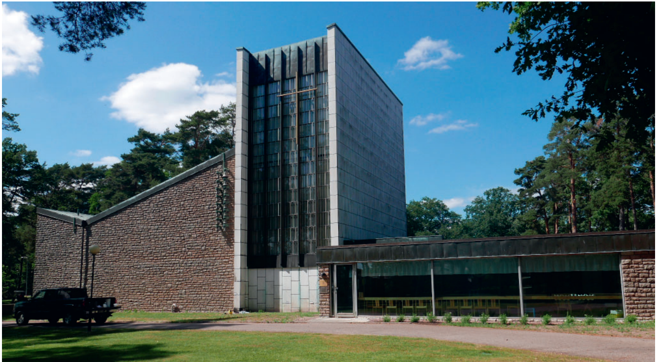
Figur 9.20. Heliga korsets kyrka i Kalmar är ett exempel på marmorbeklädnad på en stomme av betong. Kyrkan uppfördes efter ritningar av arkitekt Rudolf Holmgren och invigdes 1963. Foto: Stefan Holmgren.
