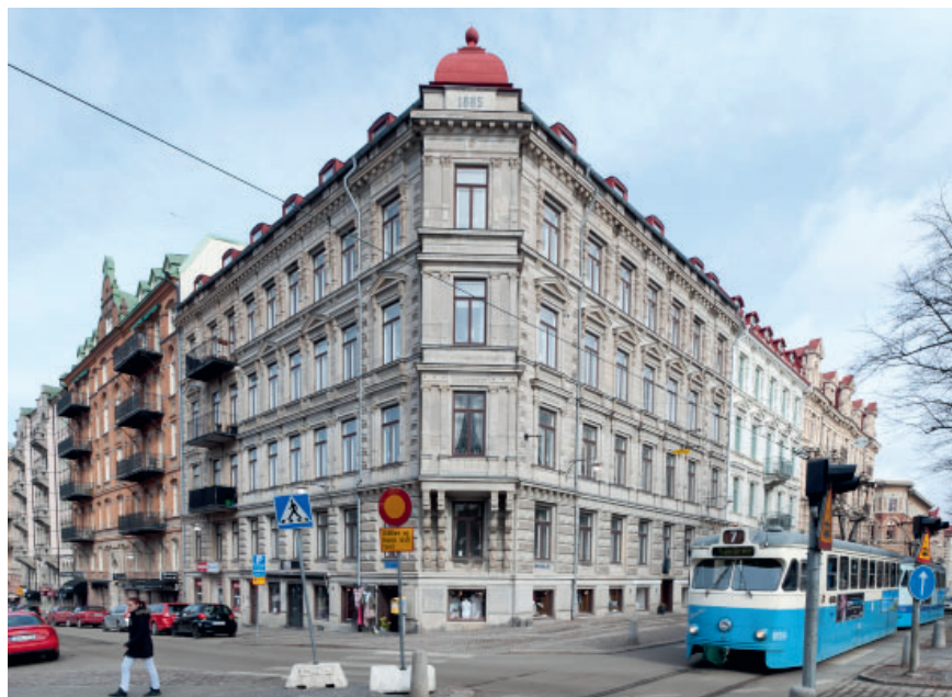
Figur 3.6. Den här fastigheten i korsningen Vasagatan och Vasaplatsen i Göteborg från 1880-talet har en fasad av betong där delar av ornamenten är gjutna med romancement. Byggnaden är restaurerad i omgångar och är sannolikt en av få i landet där den ursprungliga betongen inte är målad. Foto: Sven Olof Ahlberg, 2012.
