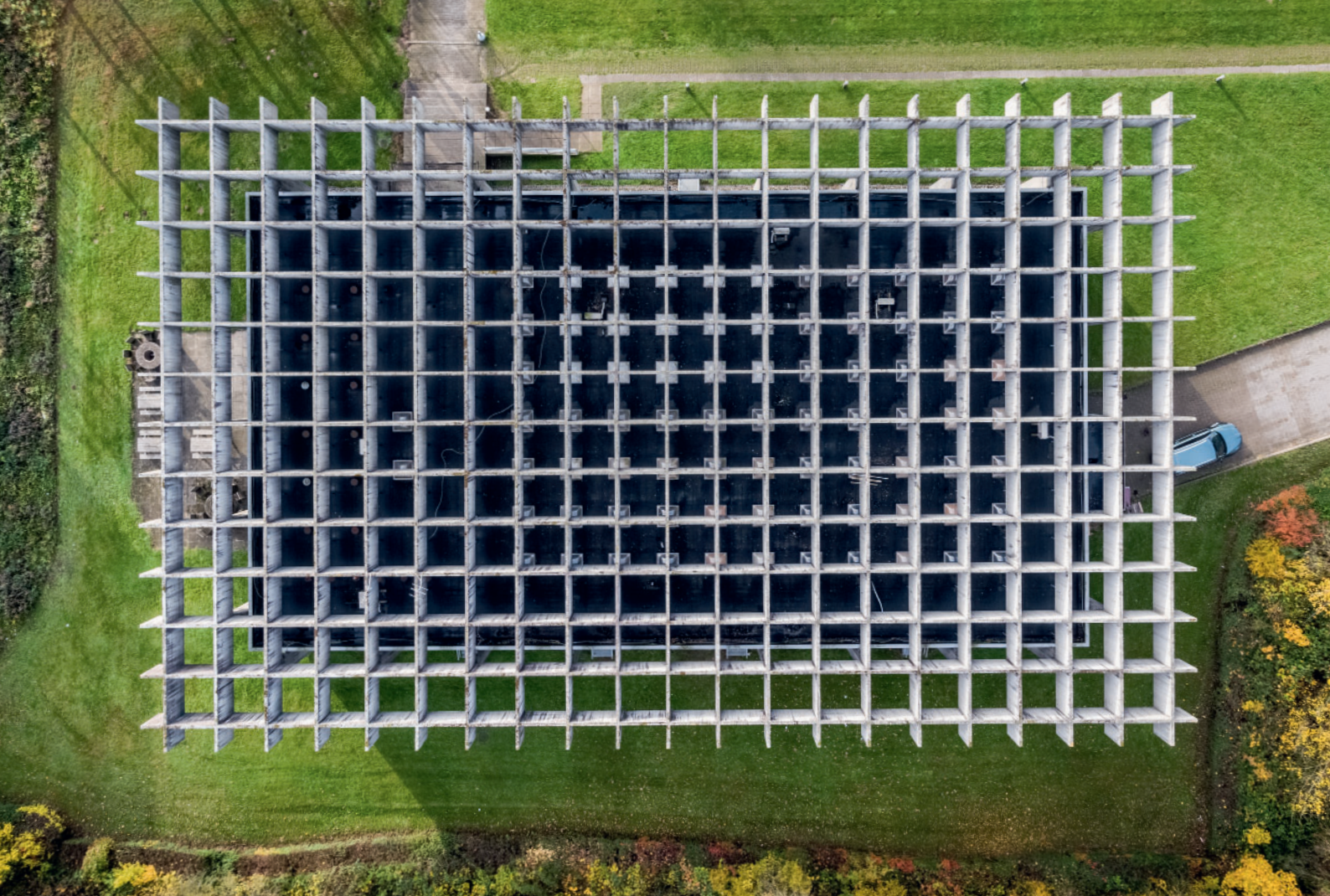
Figur 4.7. Den danska kontorsbyggnaden till glasgrossisten Glas Aalstrup uppfördes 1965-1966. Byggnadens tak hålls upp av ett 4000 m 2 stort gallerverk av betong som samtidigt silar ned ljuset till arbetsplatserna. Foto: Peter Gramstrup/Realdania By & byg, 2018.
