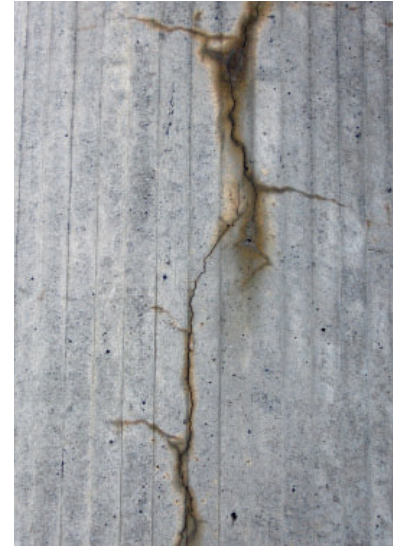
Figur 7.26. Elgeseter bro i Trondheim med ASR-skador [33]. Sprickorna i pelarna är ofta parallella med pelarnas längdriktning. Foto: Urs Müller.
