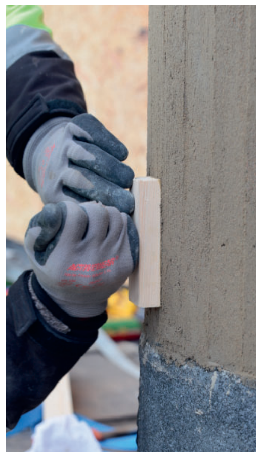
Figur 1.4. Många gånger saknas detaljerad dokumentation av utförandet. Då kan det behövas en del försök för att hitta passande ballast, kulör och ytfinish etcetera. Foto: Sven Olof Ahlberg, 2017.
