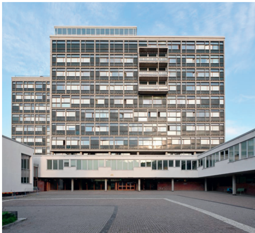
Figur 4.23. Kungsholms gymnasium är ett bra exempel på att det vid restaurering är viktigt att ställa frågan på vilket avstånd en lagning kommer att betraktas. Foto: Sven Olof Ahlberg, 2022.
