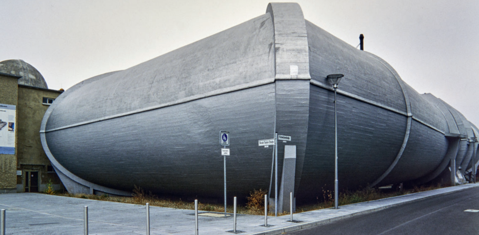
Figur 8.2. Även denna vindtunnel är en del av den tyska flygprovninganstalten i Berlin-Adersdorf. I tunneln testades flygplans aerodynamiska egenskaper. Foto. Urs Müller.
