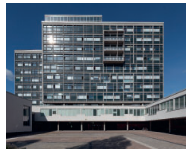
Figur 9.18. S:t Görans gymnasium är ett tidstypiskt betongmonument från 1960. Den modernistiska arkitekten Léonie Geisendorf ritade byggnaden. I samband med en ombyggnad till studentlägenheter konserverades betongfasaden. Foto: Sven Olof Ahlberg.
