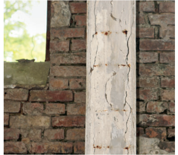
Figur 7.20. Öppen byggnadskonstruktion i Olympiabyn i Berlin från 1936. Ett exempel på armeringskorrosion orsakad av karbonatisering i en ram-bjälklagskonstruktion. Foto: Urs Müller.
