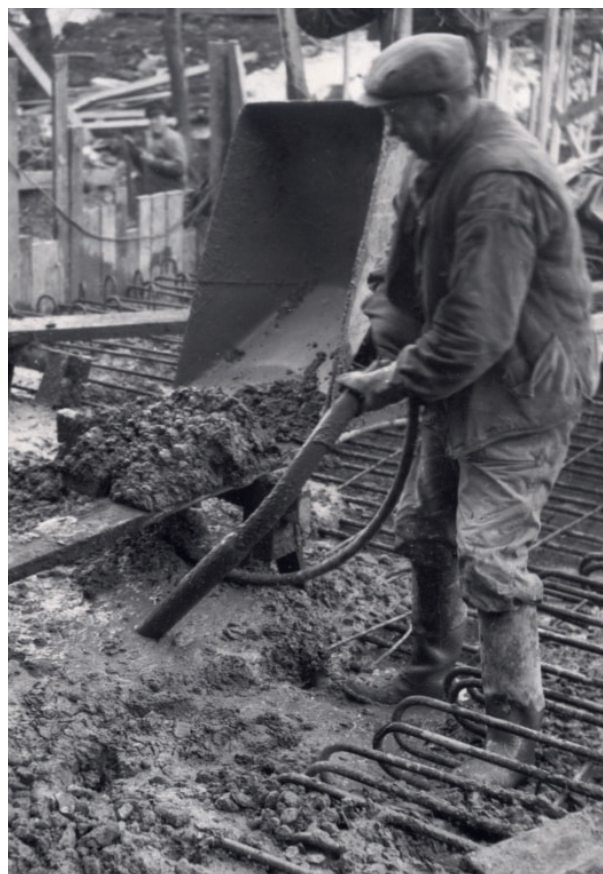
Figur 2.28 och 2.29. Två bilder visande överst formvibrering vid tillverkning av betongrör och nederst stavvibrering av ett armerat bjälklag. Vibreringen var helt avgörande för kvaliteten på det gjutna men orsakade även stora bekymmer för arbetarna, som fick vibrationsskador på händer och armar. Foto överst: Carl Larssons Fotografiska Ateljé AB, Länsmuseum Gävleborg, XLM. CL016025-16. Foto nederst: Okänd fotograf. Teknik- och industrihistoriska arkivet / Tekniska museet, TEKA0124872. Digitaltmuseum.
