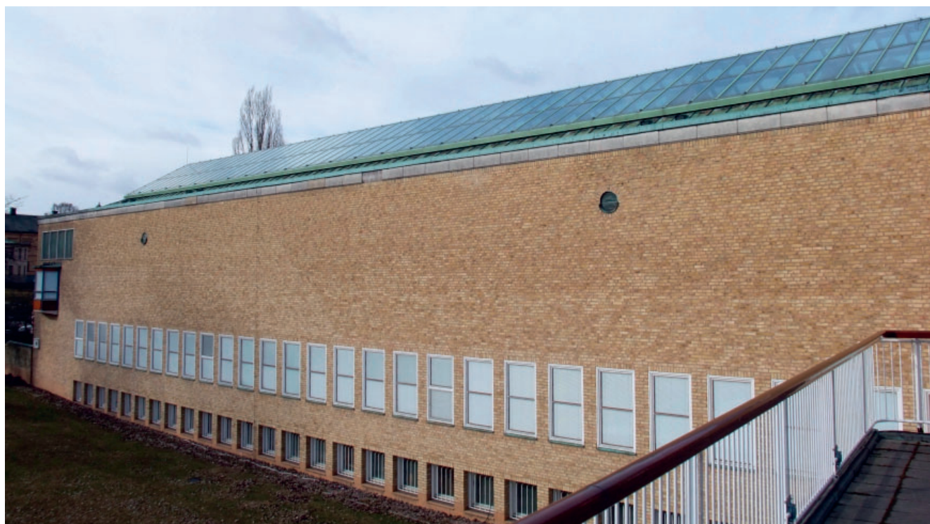
Figur 9.11. Del av östra fasaden på Östergötlands museum med en fris av betong. Fristen består av cirka en meter långa segment med ett 15 mm tjockt yttre skikt av vit betong. Detta yttre dekorativa
