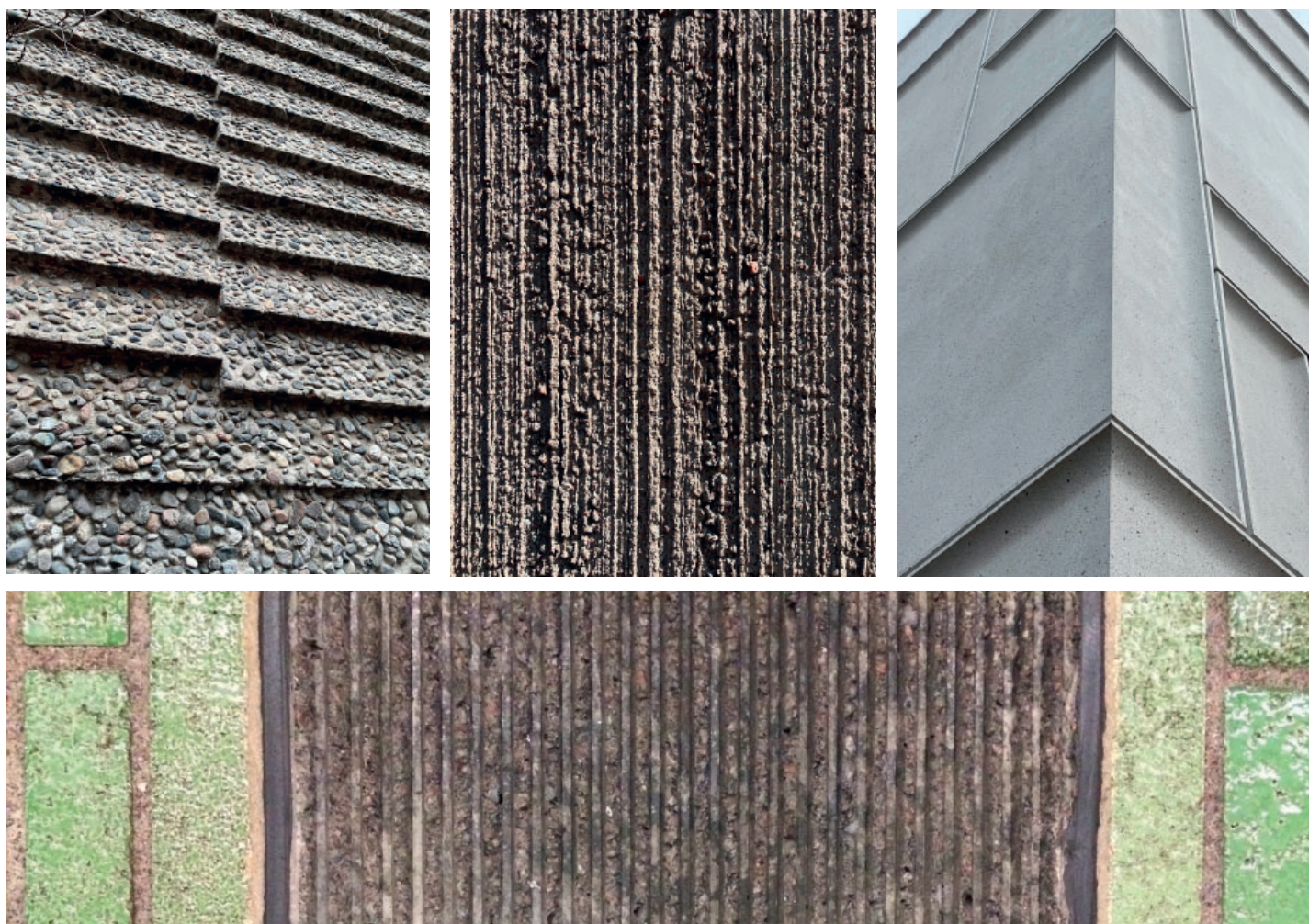
Figur 2.34. Ett urval bilder på bearbetade eller medvetet utformade betongytor. Foto: Sven Olof Ahlberg, 2019-2022.
