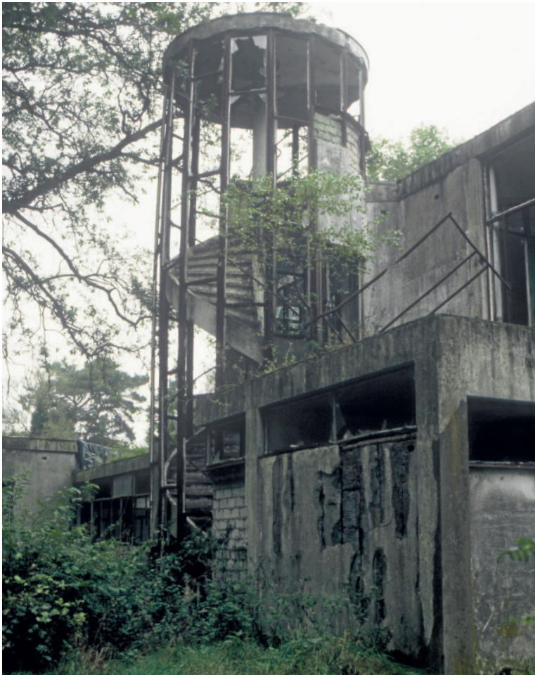
Figur 4.13. När sanatoriet Zonnestraal tomställdes utan underhåll förföll byggnaderna snabbt. Anläggningen präglades av den nya materialoptimerade betongbyggnadstekniken, och hade ytligt liggande armeringsjärn som rostade och sprängde materialet inifrån när betongen hade karboniserat. Foto: Lone-Pia Bach 1998.
