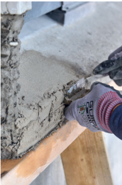
En profil påförs för hand och formas efter befintlig betong.
