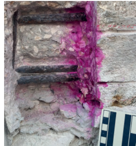
Figur 3.21. Släta armeringsstänger av stål som i regel hittas i konstruktioner uppförda före andra världskriget. Foto: Urs Müller.
