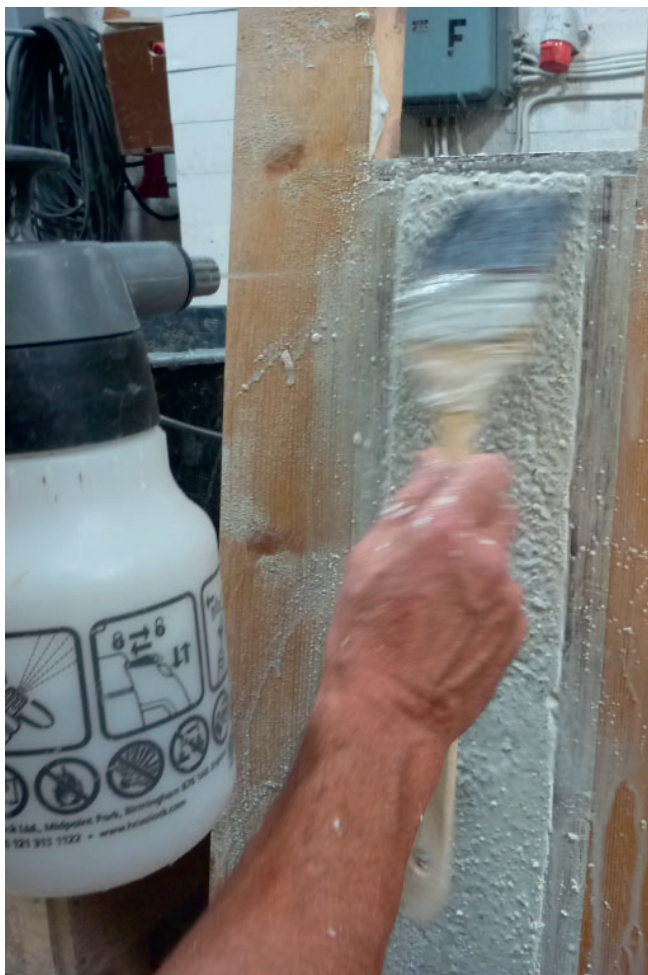
Figur 9.7. Medan betongen fortfarande var vattenlös tvättades ballasten fram med vattenspruta och pensel. Foto: Stefan Holmgren
