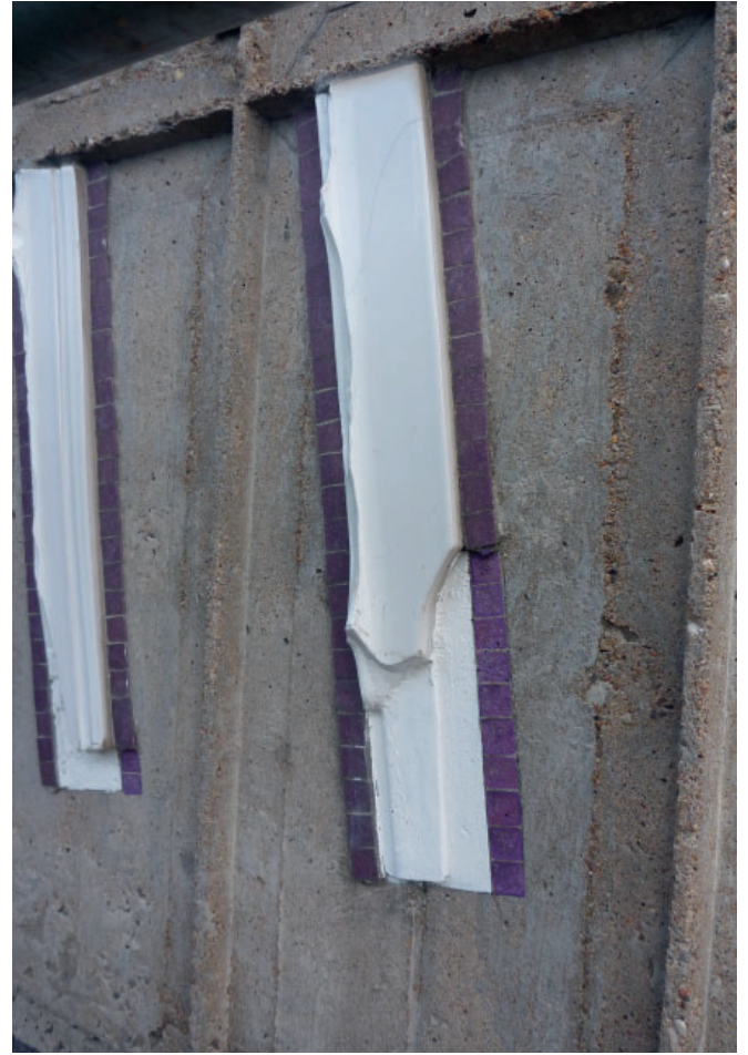
Figur 9.27. Områden där mosaik och keramik fallit bort målades för att delarna på avstånd ska uppfattas som hela. Foto: Stefan Holmgren.
