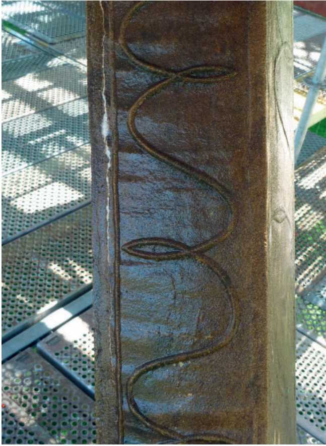
Figur 9.16. Ytan på skulpturen var täckt av alger som tvättades bort med het vatten. Foto: Stefan Holmgren.
