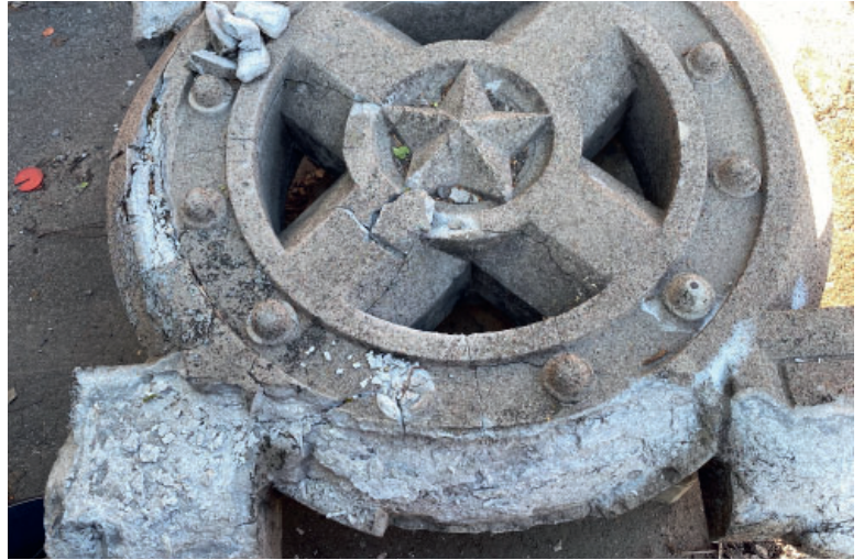
Figur 7.23. Domkyrkan i Luleå. Korset uppvisar frostsador i form av avflagnings. Foto: Sven Olof Ahlberg. 2021.
