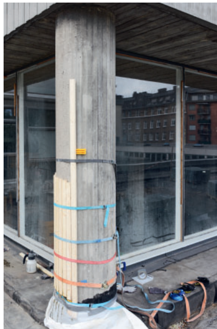
Ett exempel på en betongreparation där avtrycket av formen återskapas i det färskta reparationsmaterialet för att ge ytan ...
