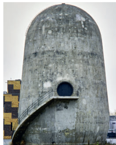
Figur 8.1. En vertikal vindtunnel som använts för att undersöka flygplan. Betongkonstruktionen är från 1930-talet och ingår i den tyska tidigare flygprovvningsanstalten i Berlin Adersdorf. Byggnaden har restaurerats och åtnjuter idag skydd som kulturminne. Foto: Urs Müller.
