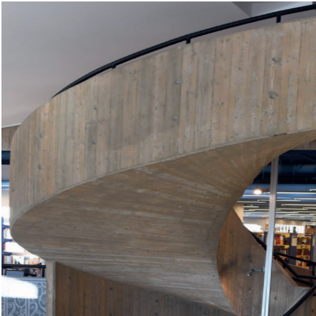
Figur 4.21. Gjutformens formbrädor blästrades för att få ett tydligare träavtryck i den gjutna betongen vid Norrköpings stadsbibliotek. Träfiber som blev kvar i formen ger betongen en mjuk gulaktig kulör som i synnerhet kan upplevas i interiören. Foto: Sven Olof Ahlberg, 2020.
