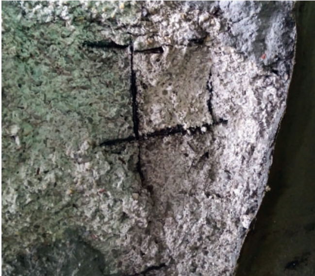
Figur 7.32. En betongdel som är allvarligt skadad av sulfatangrepp (till vänster). Det finns frilagda ballastkorn på grund av kombinerat sulfat- och syraangrepp (till höger). Båda bilderna kommer från en industrianläggning som upparbetar malm i form av metallsulfider. Foto: Urs Müller.
