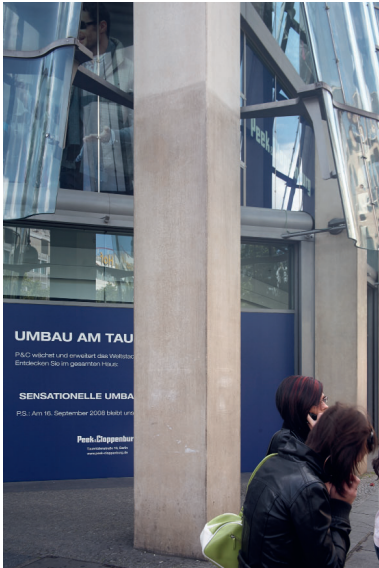
Figur 8.16. Klotterskyddssystem på betongpelare i centrala Berlin. Skyddet som applicerats från marknivå upp till tre meters höjd gör betongytan mörkare och glansigare. Foto: Urs Müller.
