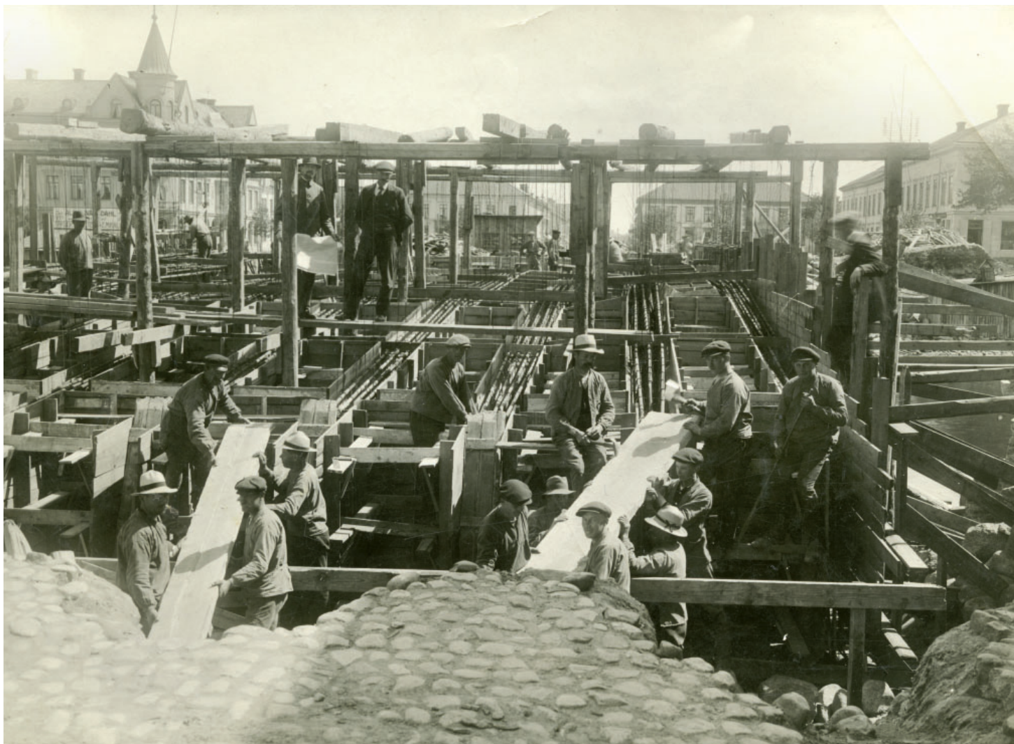
Figur 2.21. Bilden visar uppförandet av Torgbron i Lidköping ca 1914. Arbetet är beskrivet i texten på motstående sida, men det är värt att notera alla de trådar som hänger ned från träställaget för att hålla armeringsjärnen på plats i rätt höjd i gjutformarna. Foto: Vänermuseet, Lidköping.
