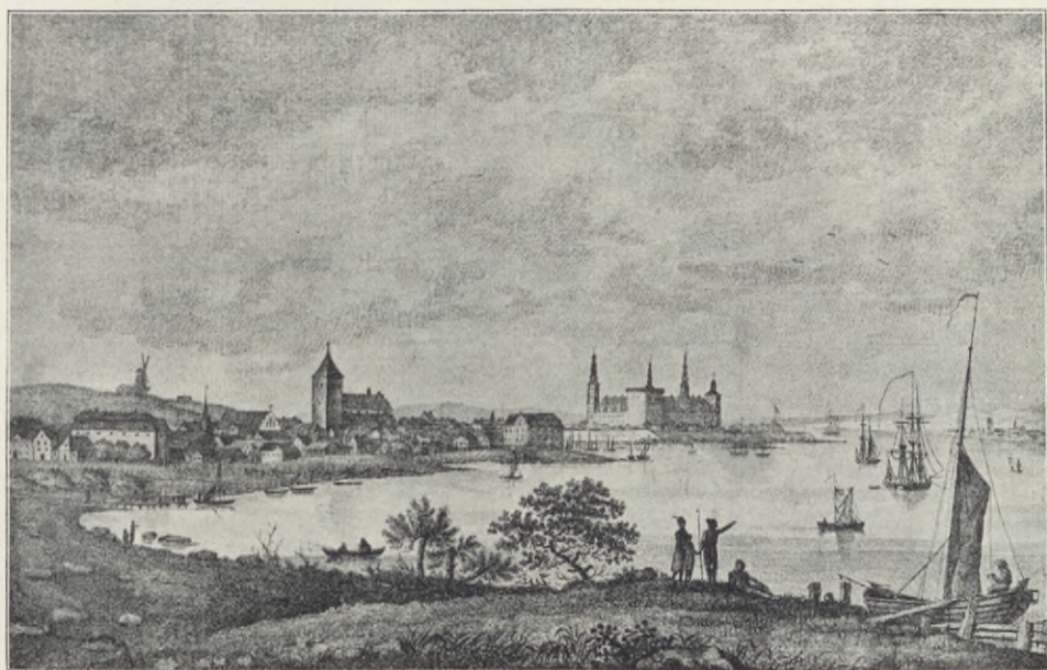
Svingelbugten med Udløbet af »Groften« set fra Sjællandsøre.
