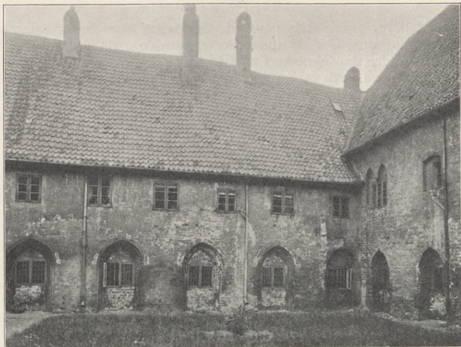
Klosterets Fratergaard før Istandsættelsen, set mod Nord. Munkegangenes Arkader tilmurede og forsynede med smaa Vinduer.
