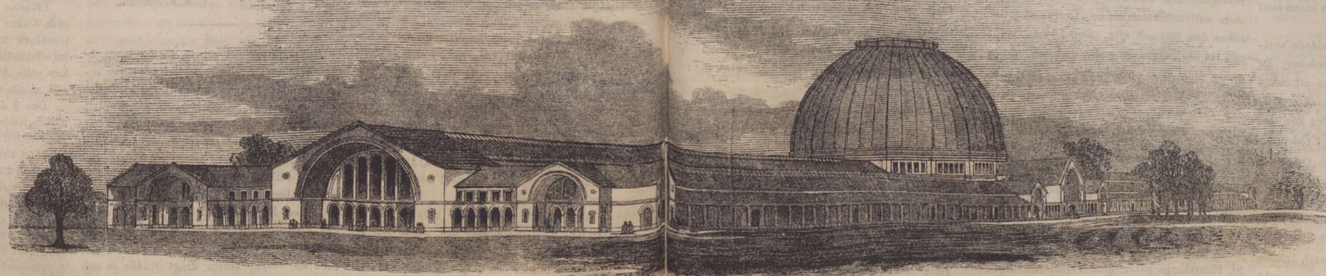
Vy af byggnaden för den stora industriutställningen i London.
