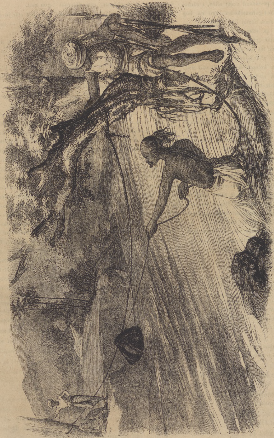
Ett sätt att föra brefsåsar öfver vatten.
