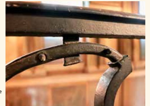
Rektangulär nit där den pånitade dekordelen försvunnit.
