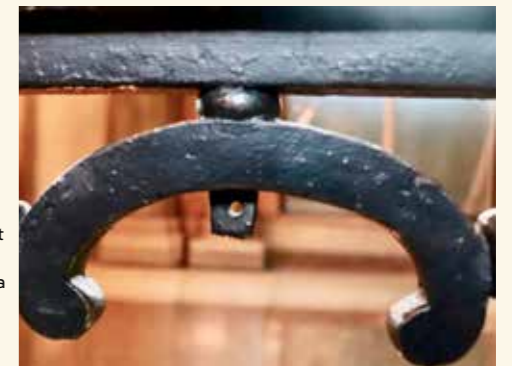
Rektangulär nit med hål för att nita eller skruva fast mindre dekordel, nu borta.
