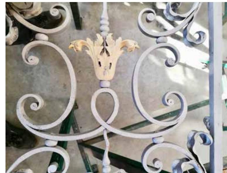
Rullade snub-end scrolls på plattjärn. 1700-talsräcke under restaurering. Foto: Vincent Lecouturier
