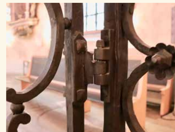
Gångjärn med originalen till vänster och de nygjorda till höger.
