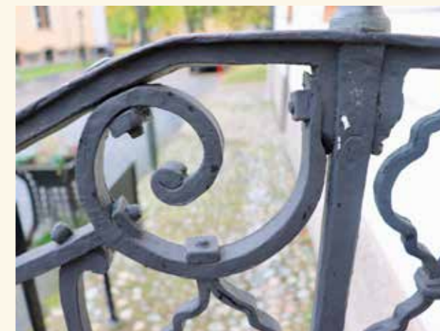
Ett fint prov på alla samlingstekniker Dachant använder. Här finns ihopskruvade samlingar med gängade muttrar, nitade kulhuvudsamlingar, svep och ändar som är vällda innan de har blivit gängade, som helhet mycket unikt och eklektiskt.
