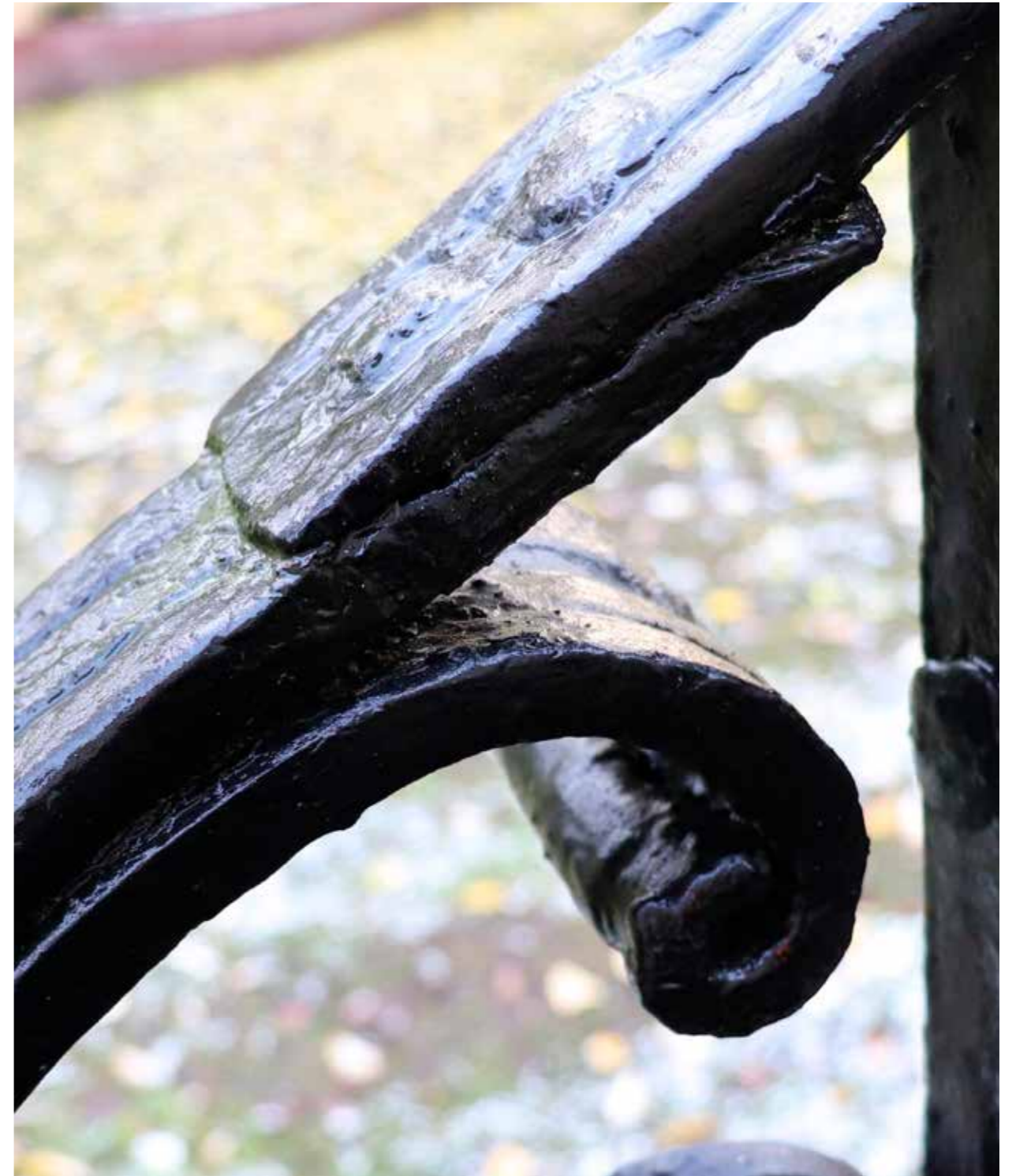
Nitad samling på trappräcke, handledare på trappa vid Gävle slott. Antagligen gjort av Christoffer Dachant.
