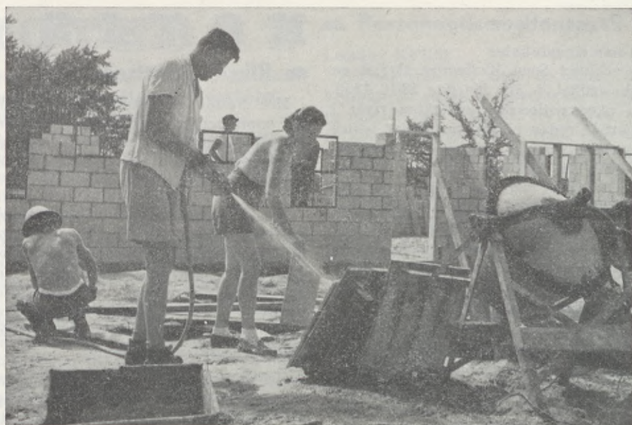
FRAN ETT ARBETSLÄGER Ungdomar i färd med att bygga en skola i södra Italien.
