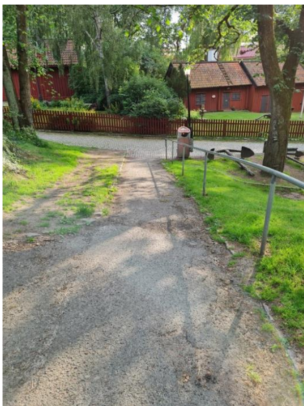
Figur 3. Samma backe som i figur 1 men denna gång under ljusa förhållanden. Notera den branta backen, höga ledstänger och det bristande underhållet (Fotograf: Nils Thörn).
