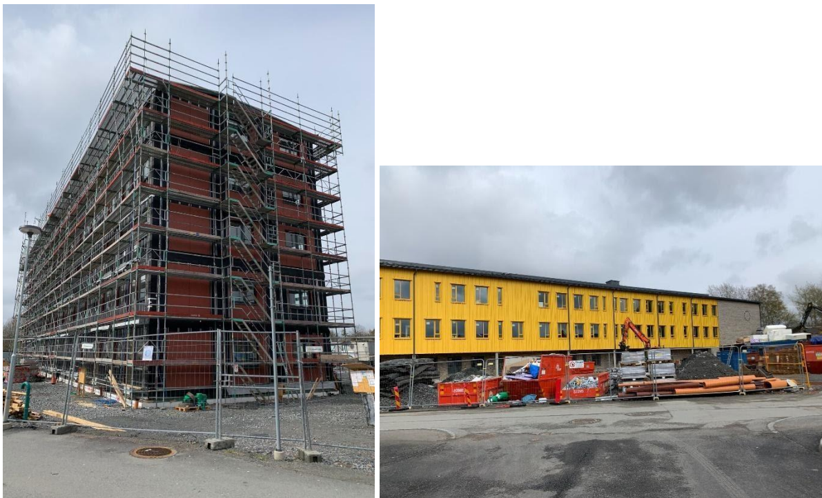
Fig. 28: Flerbostadshus under konstruktion. Fig. 29: Nya skolan under konstruktion.
