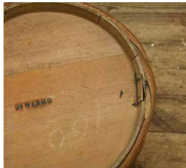
Den svagaste delen på ett laggkärl är insidan av stavarna, nedanför laggen.
