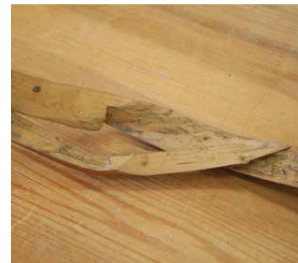
Haket på banden som håller ihop kärlet.
