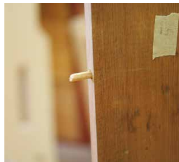
Pinnen som håller stavarna på plats upptill.
