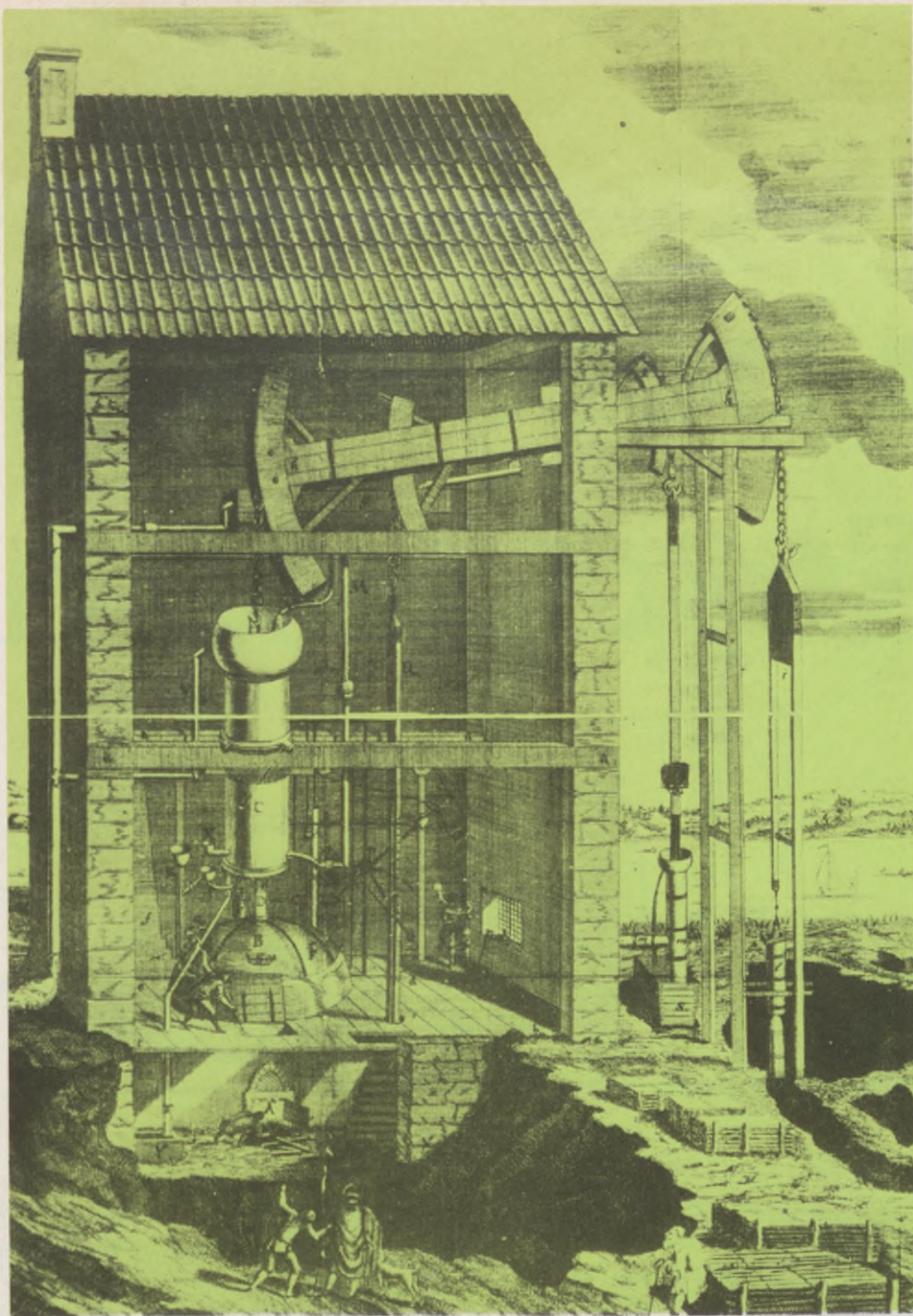
Mårten Triewalds "eld- och luftmachin" vid Dannemora gruvor i Uppland. Uppförd mellan åren 1726—28. - Kopparstick från 1730-talet.
