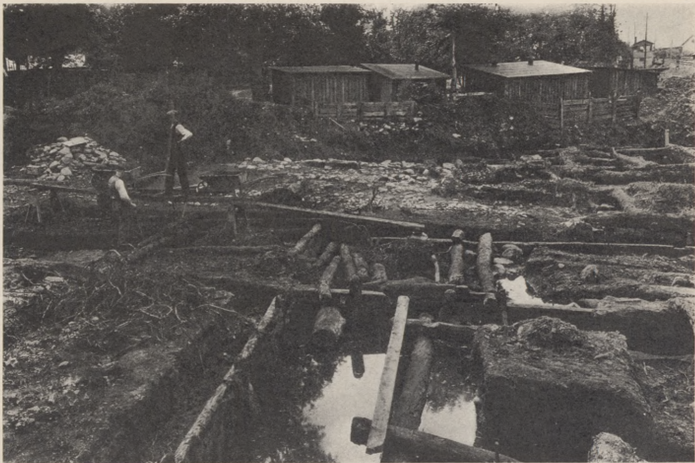
Nya Lödöse. Stockkonstruktioner och pålning
