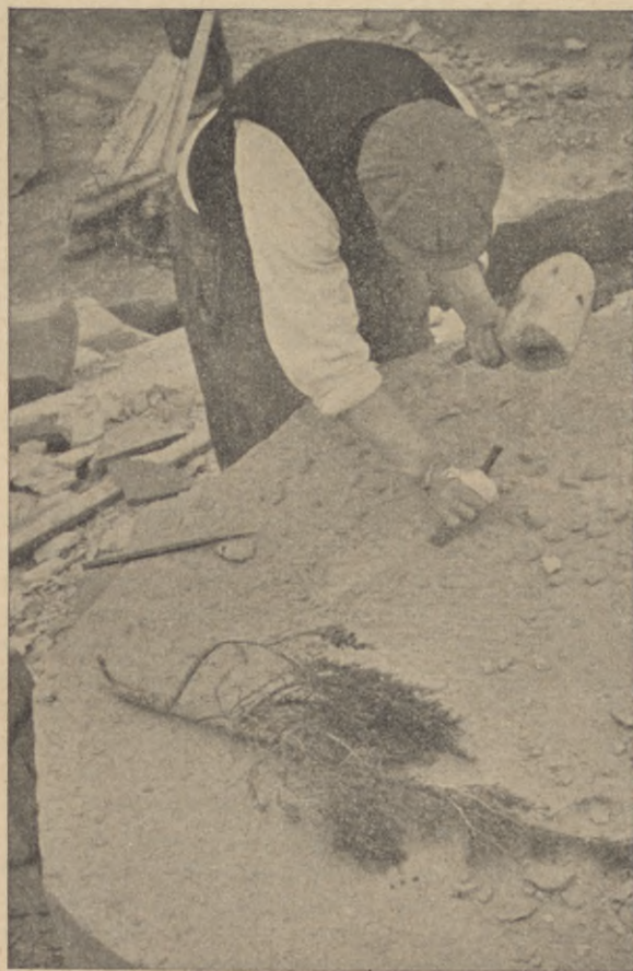
Finhuggning av block är ett tidsödande arbete, som kräver både goda verktyg och yrkesskicklighet.
