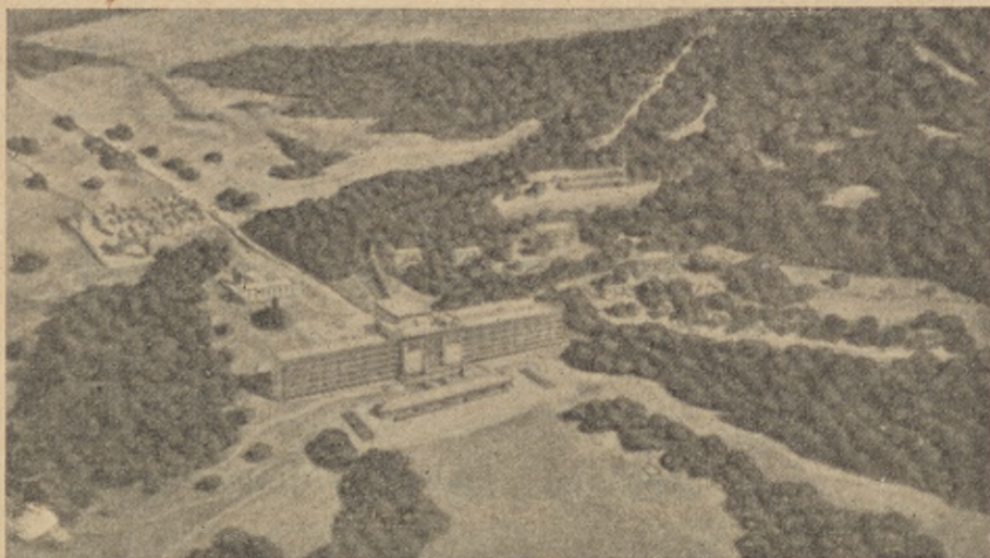
Bensmin Sanatorium i Marocko som just är under byggnad.
