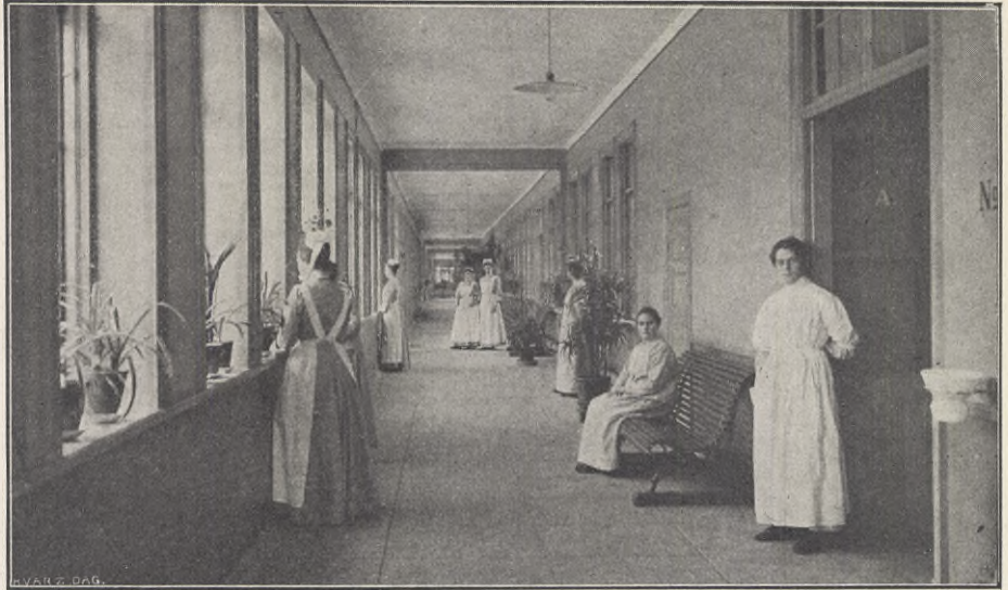
SABBATSBERGS SJUKHUS: Korridor.
