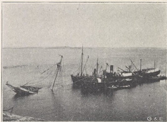
Allt i ordning för lyftning, juni 1900 (Bärgningsarbetet hade då pågått sedan april.)
