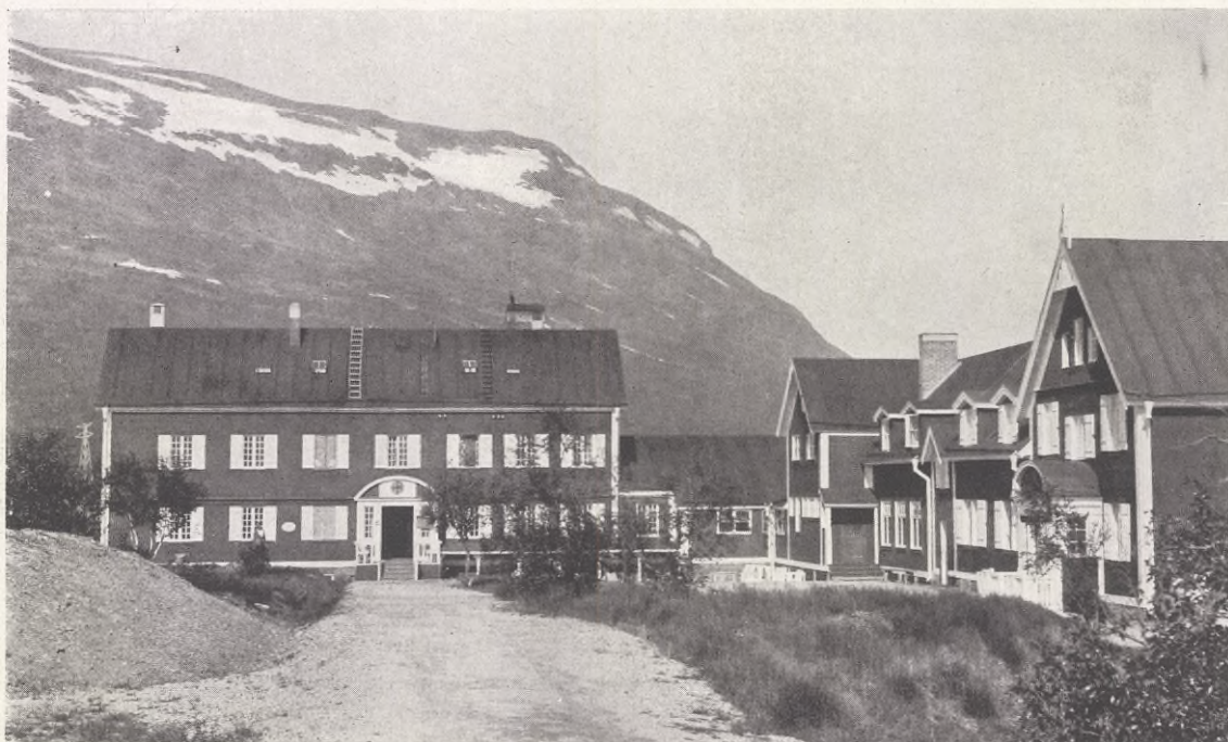
ABISKO TURISTSTATION MED NY-TILLBYGGNAD.
