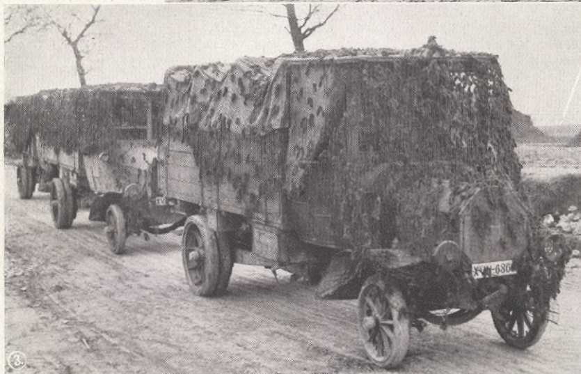
1 TYSK LUFTSKEPPS-HALL, SOM TILL SKYDD MOT FLYGARE MÅLATS TILL ETT LANDSKAP. 2 MED NÄT ÖFVERDRAGEN ENGELSK LÅNGSKJUTANDE KANON; eröfrad under senaste offensiv. 3. LASTBILAR FÖRSEDDA MED SKYDDSNÄT MOT FLYGARSPANING.
