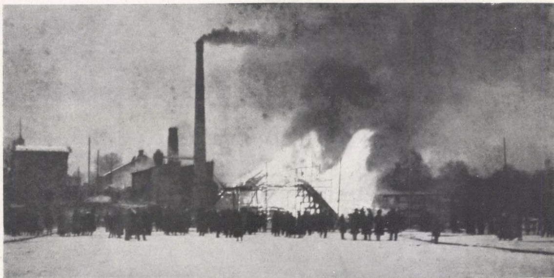
BOLLNÄS SKIDFABRIKS BRAND DEN 15 NOV. — Foto. Sohlberg, Bollnäs.
