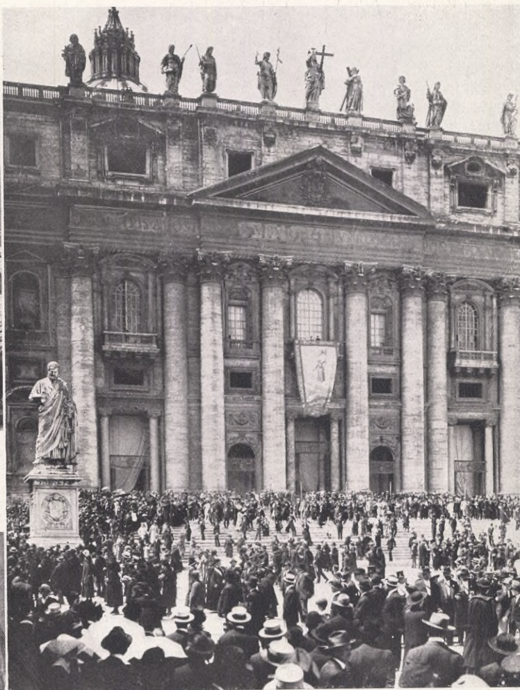
2-3. FRÅN KANONISERINGEN I ROM. 2. Framför S:t Peterskyrkan under kanoniseringen. Märk det berömda Jeanne d'Arc-baneret upphängt över ingången till kyrkan.
