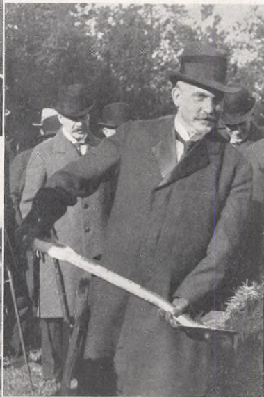
Pressfoto. LANDSHÖFDING M. SAHLIN tar första spadtaget till järnvägsbygget Faringe-Gimo .
