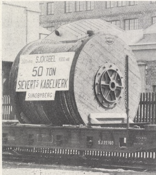
EN SVENSK JÄTTEKABEL tillverkad vid Sieverts kabelfabrik, Sundbyberg.
